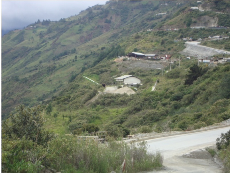
Fotografía N°17: Ex taller mecánico. (Vista desde Concretera) Fuente: Elaboración propia
