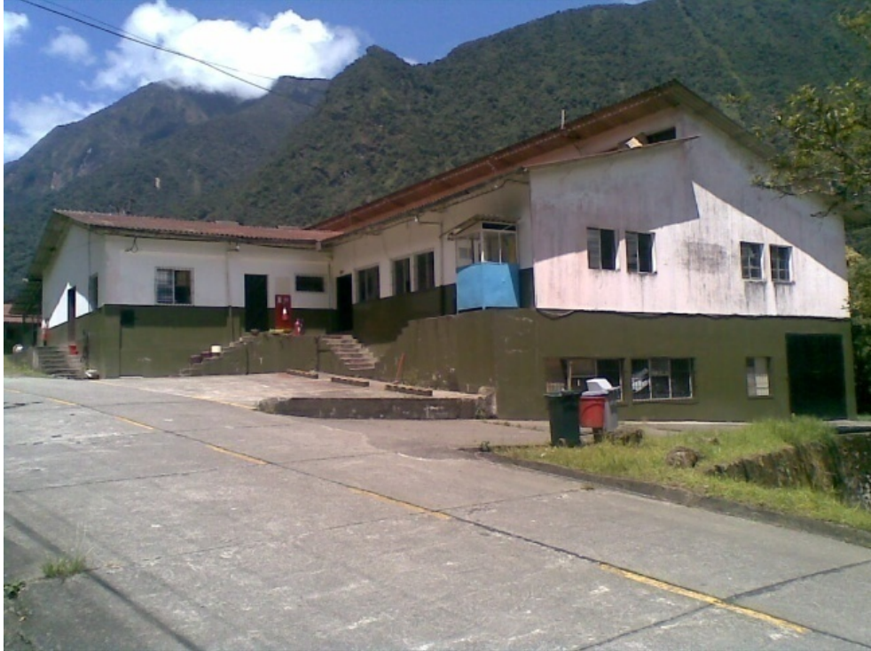
Fotografía N°5: Infraestructura del Edificio Principal de las bodegas de la Central Molino Fuente: Elaboración propia
