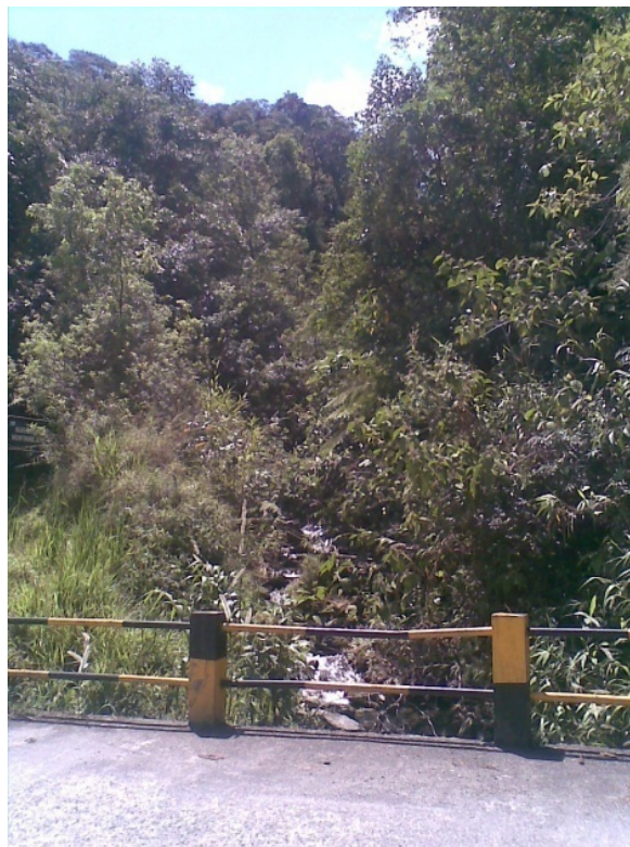
Fotografía N°4: Quebrada Ventanillas Fuente: Elaboración propia.
