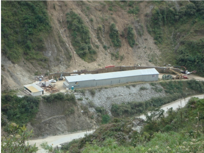
Fotografía N°15: Bodega de la Constructora Santos C.M.I. (Vista aérea) Fuente: Elaboración propia
