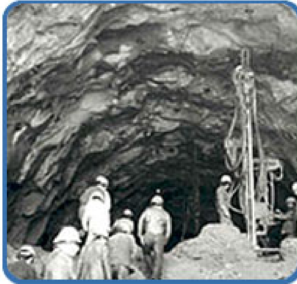
Fotografía N°1: Trabajos de construcción de la Presa Daniel Palacios. Fuente: HIDROPAUTE EP
