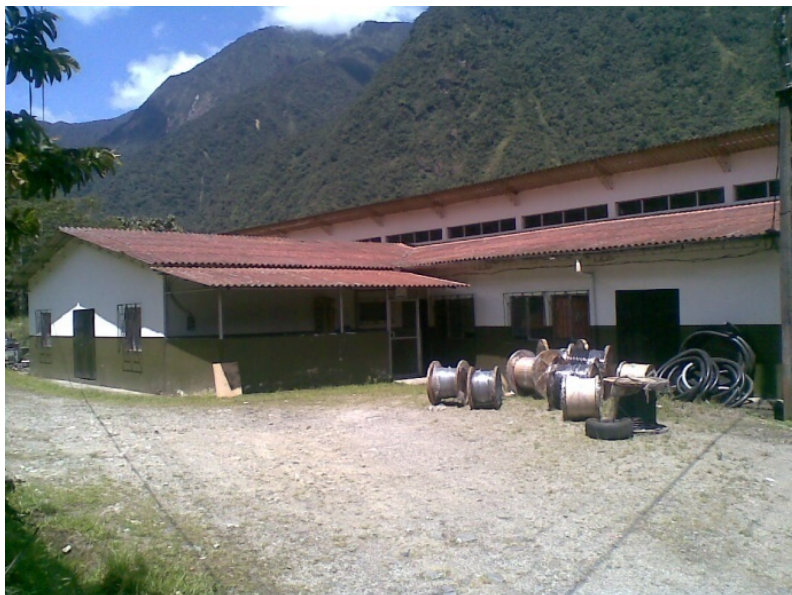
Fotografía N°6: Infraestructura del Edificio Secundario de las bodegas de la Central Molino
