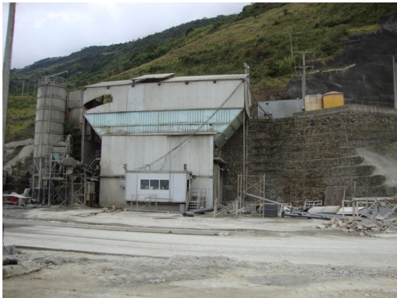
Fotografía N°18: Concretera (Vista frontal) Fuente: Elaboración propia
