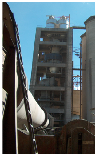
Figura 9. Vista de los ciclones del precalentador.
