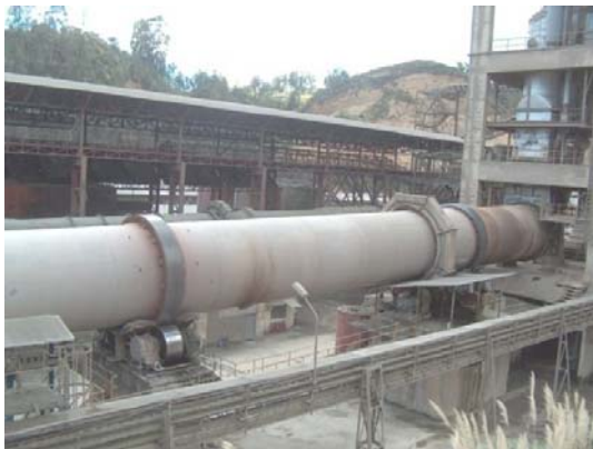
Figura 8 Vista longitudinal del Horno de Clinkerizacion.
