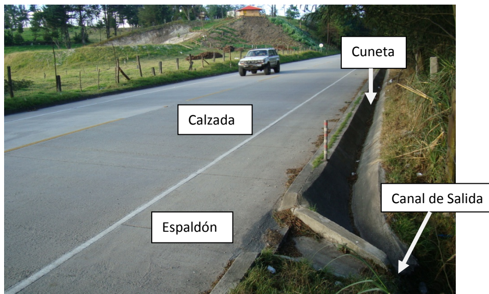
Foto 1. Sistema de drenaje y partes de la infraestructura vial (Vía Girón-Santa Isabel)
