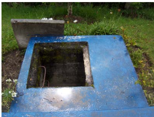
Foto II-9 Cámara de Desagüe del Floculador y Sedimentador.
