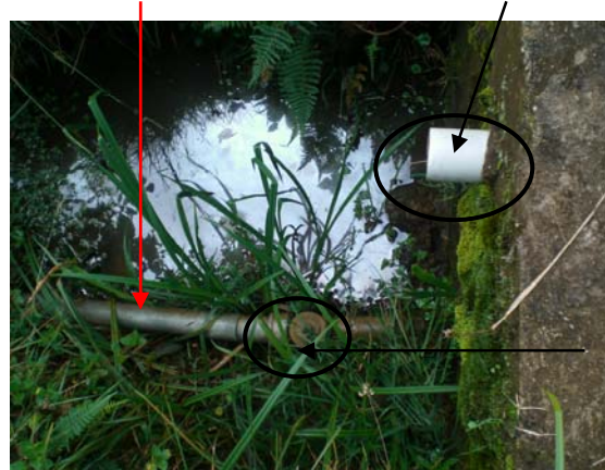
Foto V-13 Tubería de salida, de rebose y llave de paso
