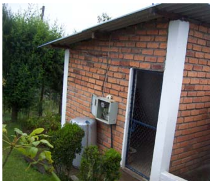
Foto II-24 Caseta para el Hidroneumático
