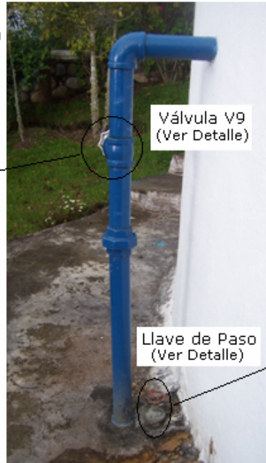
Foto X-13 Desagüe del Filtro 1
