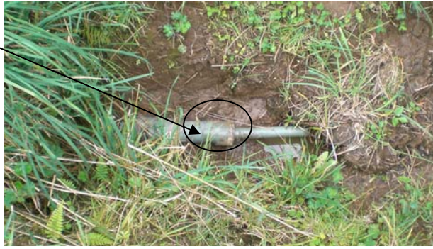
Foto V-37 Reductor de PVC en la Tubería de Salida.
