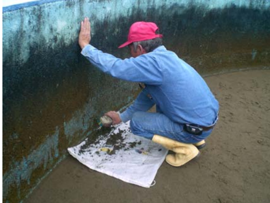
Foto VI-16 Operador raspando las paredes del filtro lento
