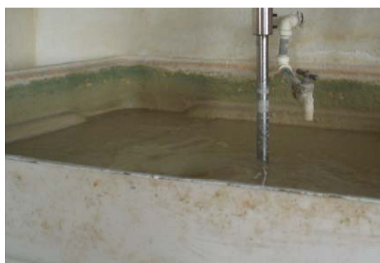
Foto X-39 Interior del Tanque de Mezcla.
