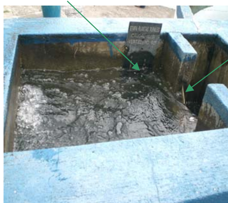
Foto VII-2 Vertedero del filtro lento derecho
