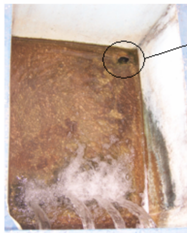
Foto X-3 Inicio de la Tubería de Salida del Sedimentador.
