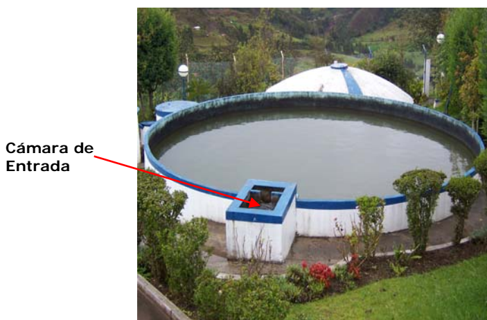
Foto II-14 Filtro Lento Arena
