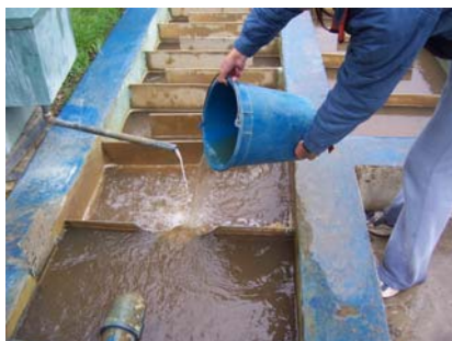
Foto VII-4 Adición del trazador en la cámara de mezcla rápida
