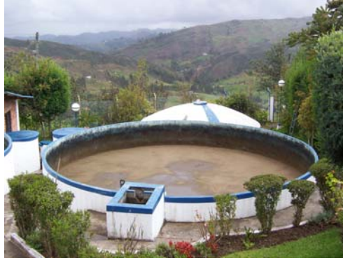
Foto VI-19 Filtro nivelado, listo para su llenado
