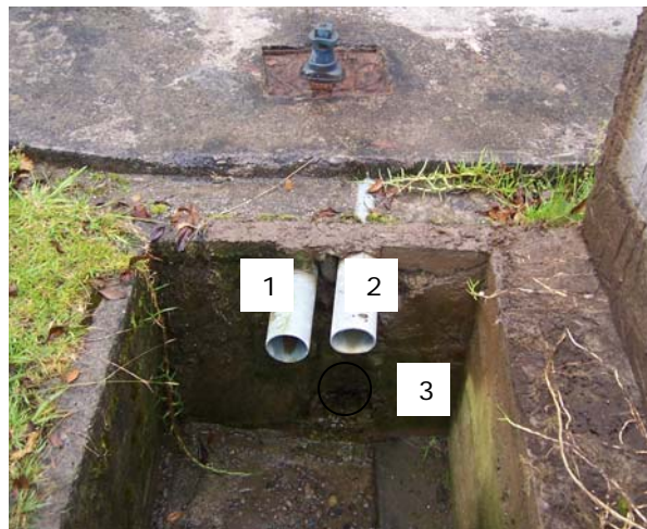
Foto X-35 Tuberías que desaguan en la Cámara
