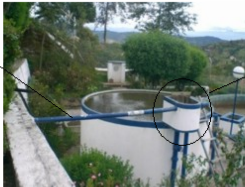
Foto X-4 Tramo Final de la Tubería de Salida del Sedimentador
