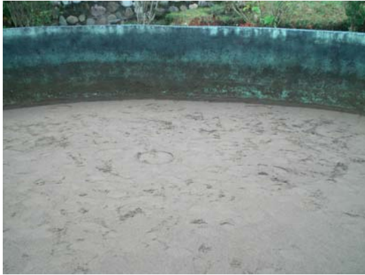
Foto IX-19 Pared Interna del Filtro Lento de Arena enmohecido. condiciones.
