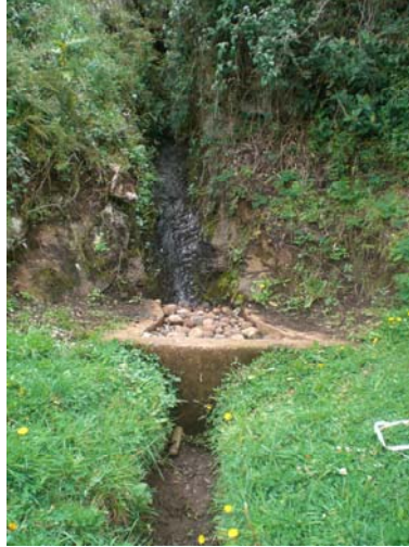
Foto. V-25 Vista panorámica de la captación 6.
