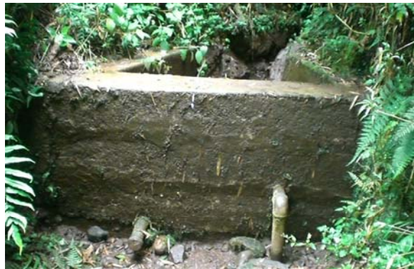
Foto V-16 Estructura de la Captación 4
