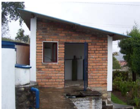
Foto XV-2 Caseta de Cloración para el Hidroneumático
