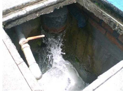
Foto VI-12 cámara de desfogue
