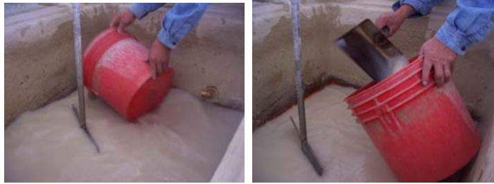
Foto VI-1 Vaciado del Tanque de Mezcla de Sulfato de Aluminio.
