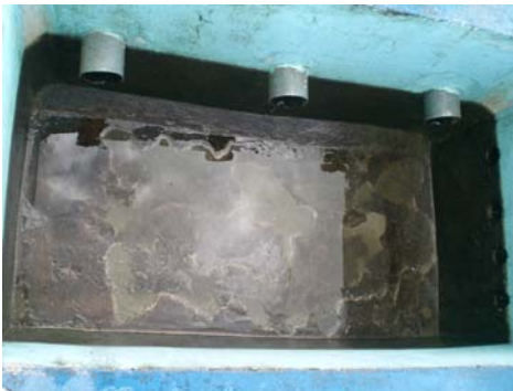
Foto IX-11 Desgaste del fondo del Canal de Recolección
