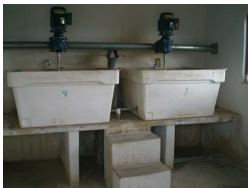
Foto X-38 Tanques de Mezcla de la Solución de Sulfato de Aluminio
