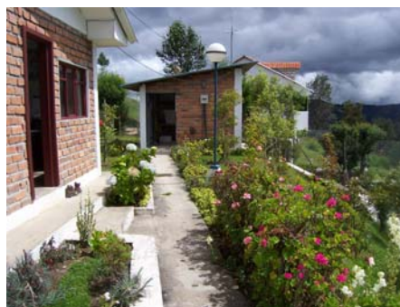
Foto XV-7 Camino hacia la Casa de Sedimentador y Casa del Operador
