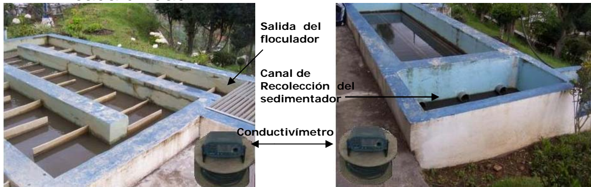
Foto VII-7 Medida de la conductividad a la salida del floculador
