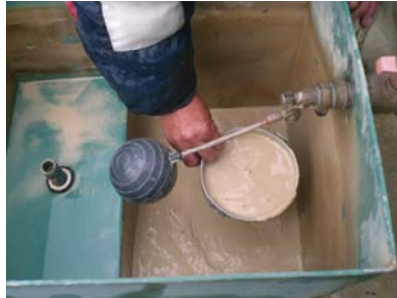
Foto VI-7 Limpieza del Dosificador
