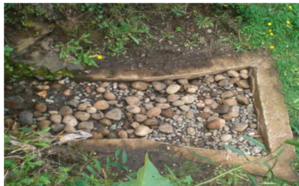
Foto. V-23 Vista en planta de la Captación 6.
