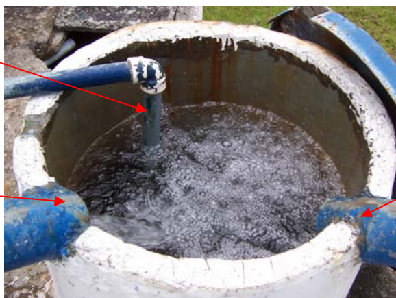
Foto II-20 Interior de la Cámara de Contacto con el Desinfectante.
