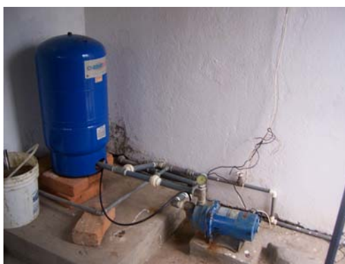
Foto X-37 Hidroneumático.
