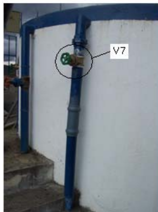
Foto X-10 Salida del Filtro Grueso al Filtro Lento 2.
