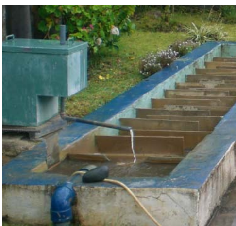
Foto XI-1: Dosificador de Sulfato de Aluminio
