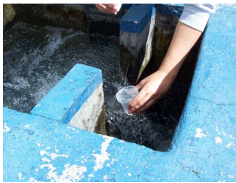
Foto XIII-16 Muestra a la Salida del Filtro Grueso.
