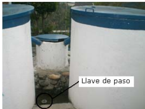
Foto X-16 Llave que permite el paso del agua del un tanque al otro.
