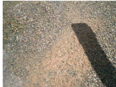
Foto IX-14 Bolas de lodo en la capa superior
