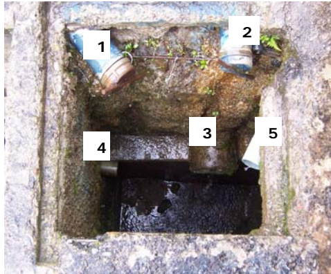
Foto X-32 Tuberías que desaguan en la Cámara
