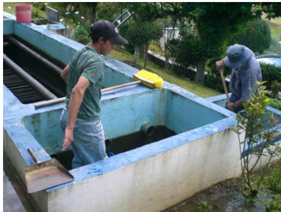
Foto VI-10 Personal realizando la Limpieza del Canal de Recolección y la Cámara de Salida del Sedimentador
