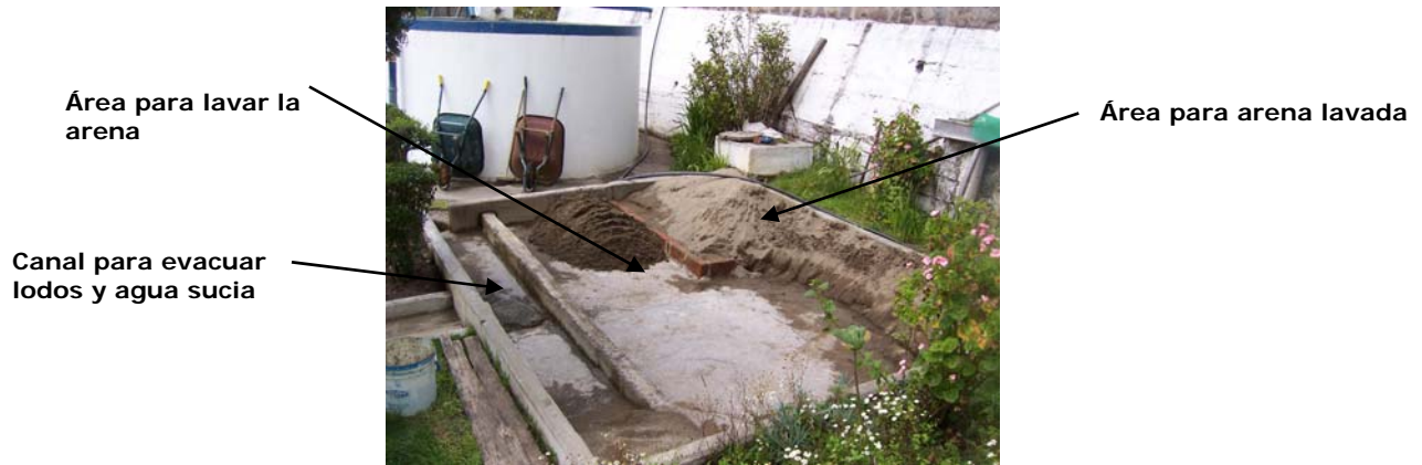
Foto VI-21 Partes de la Unidad de Lavado de Arena
