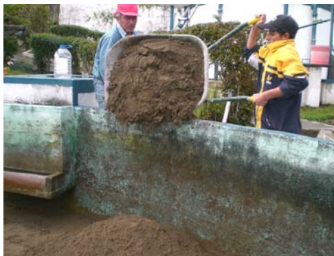
Foto VI-17 Colocado de arena limpia
