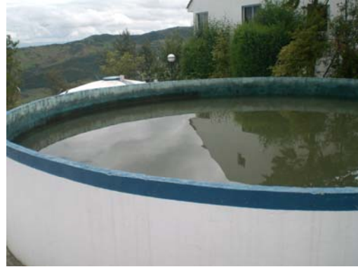
Foto IX-20 Pared Exterior del Filtro Lento de Arena en buenas condiciones.
