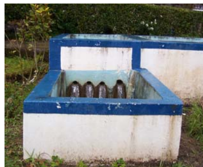
Foto II-8 Cámara de Salida
