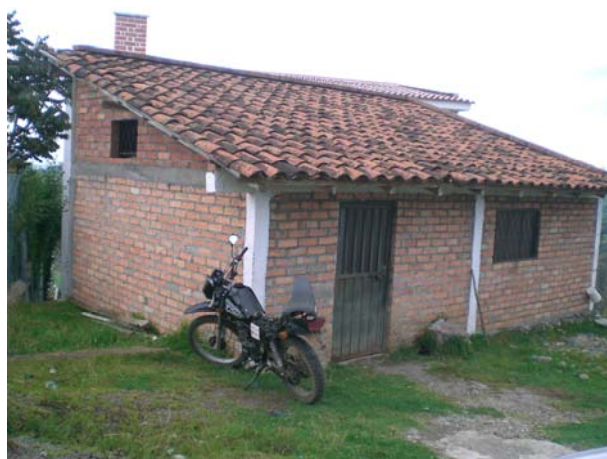
Foto XV-5 Bodega de Materiales
