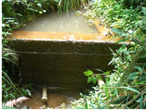
Foto. V-19 Estructura de la Captación 5
