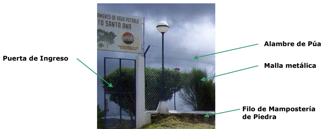
Foto XV-10 Cerramiento y Puerta de Entrada
