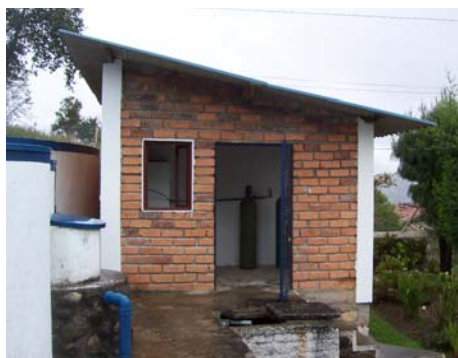
Foto II-23 Caseta de Cloración
