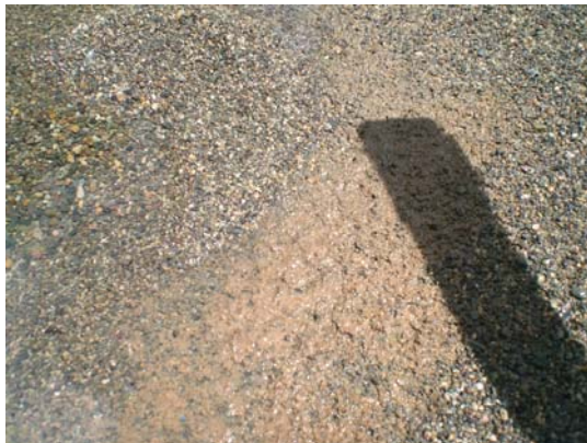
Foto VI-15 Capa Superior con lodos e impurezas
