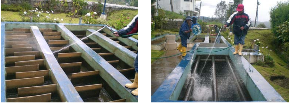
Foto VI-9 Personal realizando la limpieza del Floculador y Sedimentador
