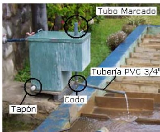
Foto X-46 Dosificador y sus Accesorios.
