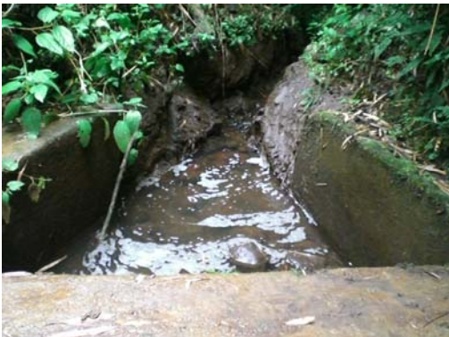
Foto V-15 Entrada del Agua a la Estructura de Captación
