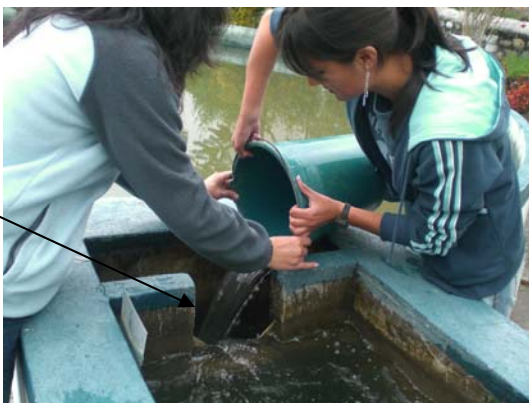
Foto VII-6 Adición del trazador en la cámara de entrada al filtro lento
