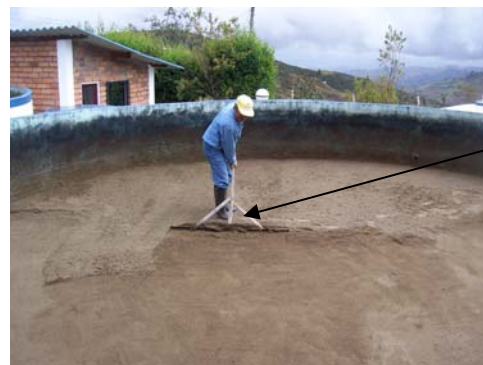
Foto VI-18 Tendido de arena
