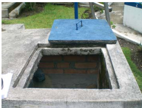
Foto IX-23 Parte externa de la Cámara de Desagüe del Prefiltro.
