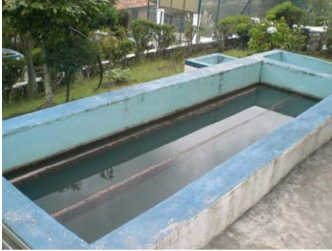
Foto IX-7 Paredes del sedimentador en condiciones aceptables.
