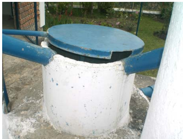
Foto IX-21 Cámara de Contacto con el Desinfectante
