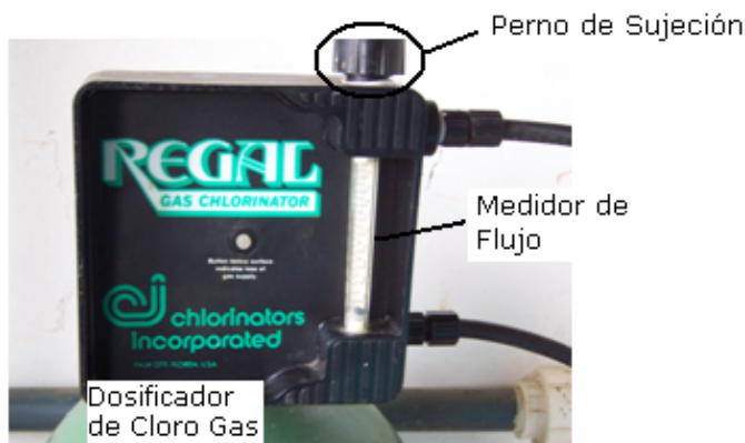
Foto X-49 Dosificador de Cloro Gas
