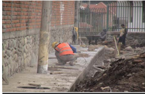
Corte de vereda con amoladora
