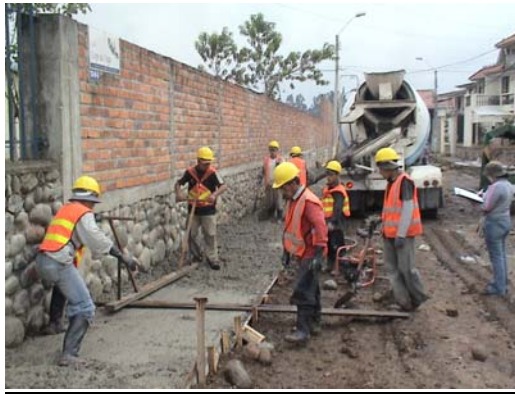
Construcción de cámara para ductos telefónicos
