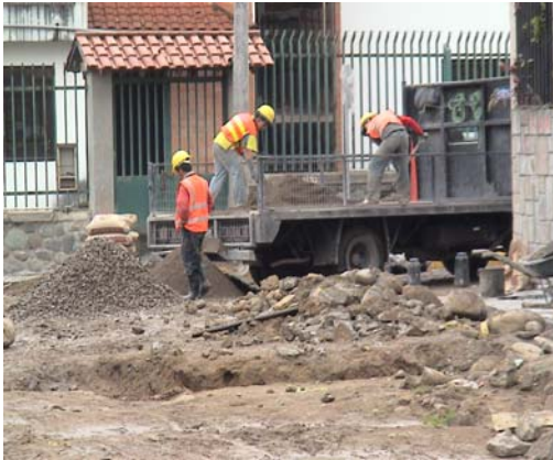
Retiro de material
