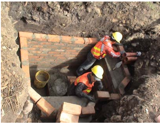
Construcción de cámara para ductos telefónicos
