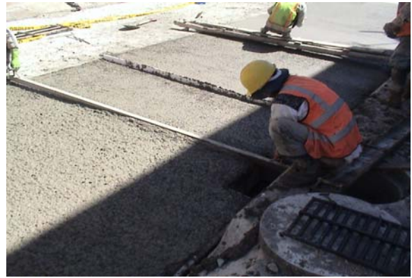
Nivelación de hormigón
