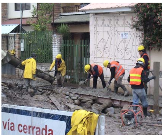
Fundición de vereda
