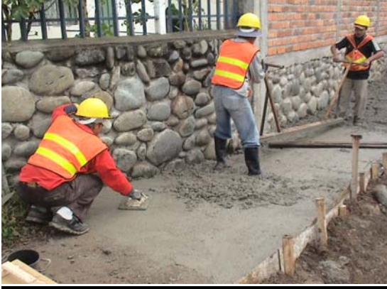
Nivelación y Enlucido de vereda.
