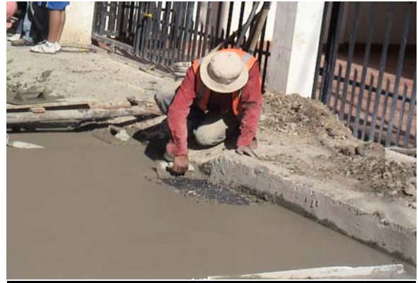
Nivelación de hormigón
