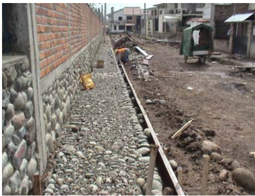
Colocación de encofrado de vereda derecha
