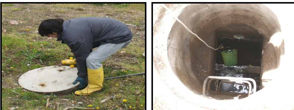
Figura 47: Efluente del Humedal (EH)
