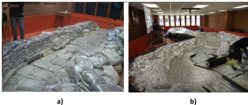
Figura 3-5. Configuración del Cauce y Lecho Mayor del Río Negro. a) colocación de sacos de arena. b) colocación de chova
