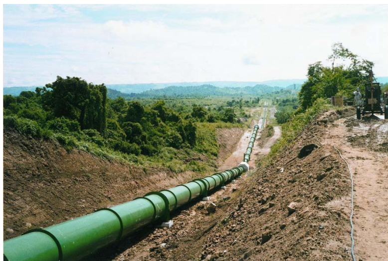
Fotografía 6.1 Línea de conducción
