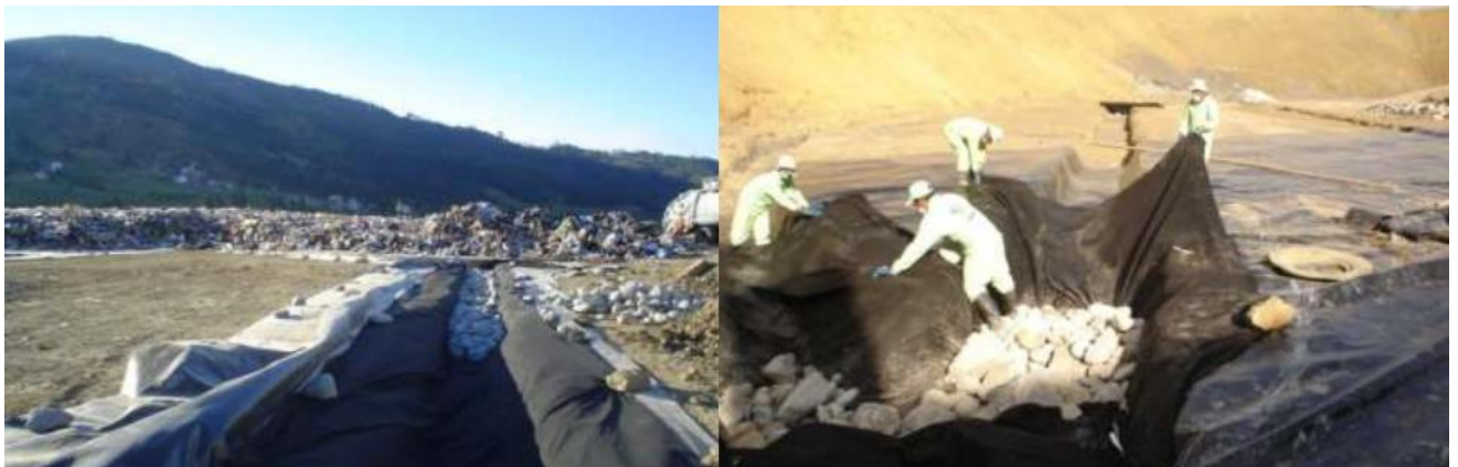
Figura 4.2 Sistema de recolección de lixiviados
