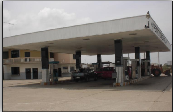
Foto 73. Estación de servicio Monterrey Elaborado por: Arq. Fabiola Segarra Gómez
