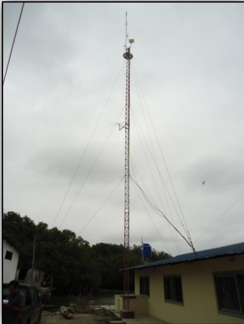
Foto 26. Torre de comunicaciones en Puerto Pitahaya Elaborado por: Arq. Fabiola Segarra Gómez
