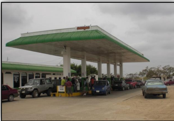
Foto 74. Estación de servicio Retosal Elaborado por: Arq. Fabiola Segarra Gómez
