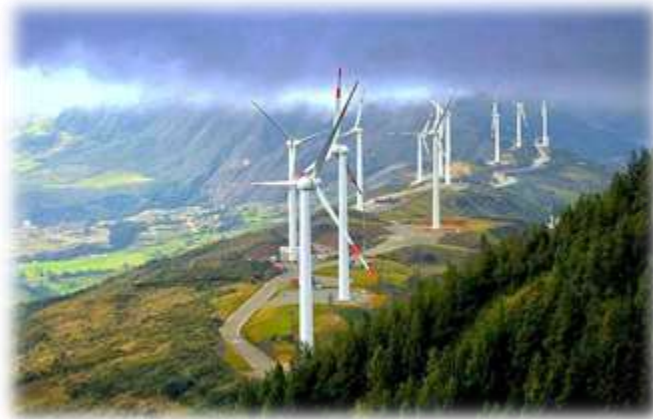
Imagen 3: Central Eólica de Villonaco en la provincia de Loja Fuente: www.energia.gob.ec/villonaco
