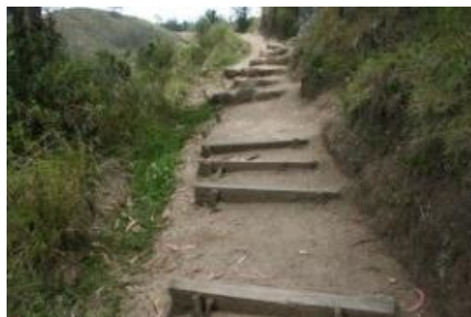
Ilustración 16: Estado del sendero
