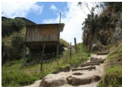
Ilustración 15: Estado del sendero
