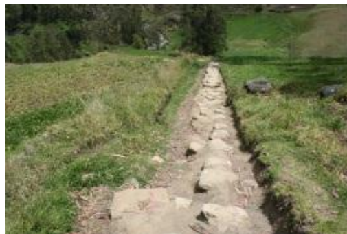
Ilustración 14: Estado del sendero
