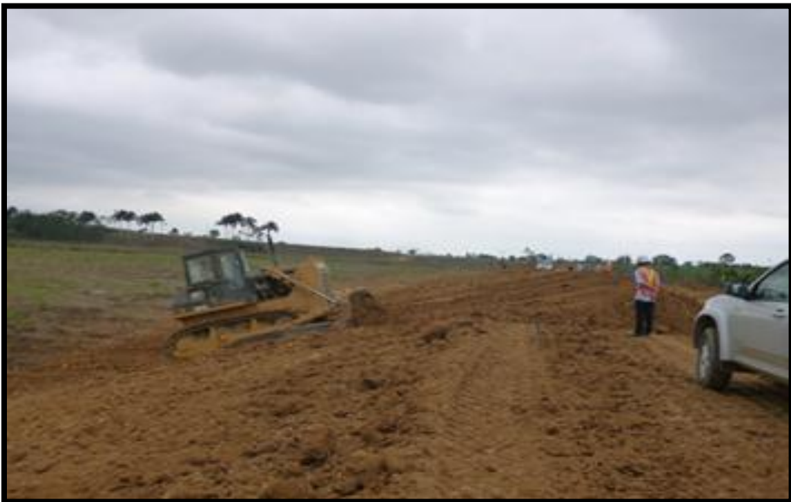
Fotografía 17. Perfilado de taludes
