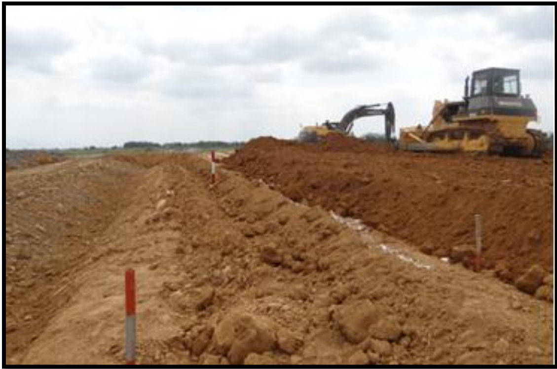
Fotografía 16. Conformación del dique mediante capas
