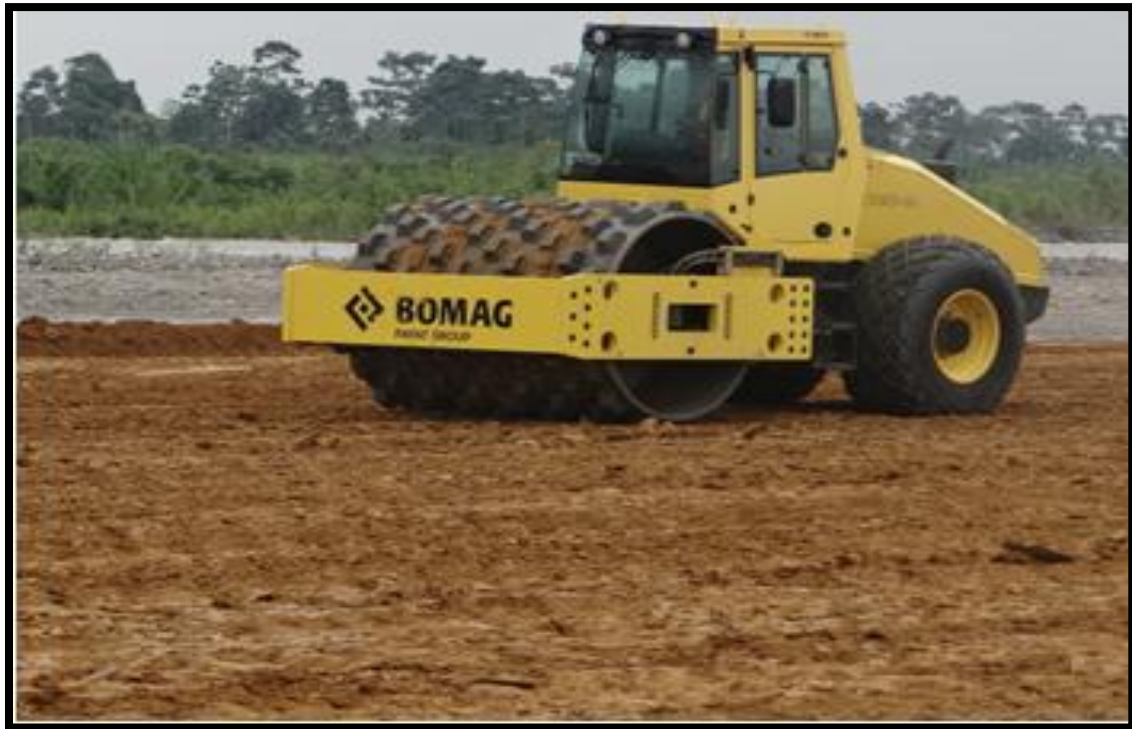
Fotografía 12. Material arcilloso compactado con rodillo vibratorio pata de cabra, autopropulsado.
