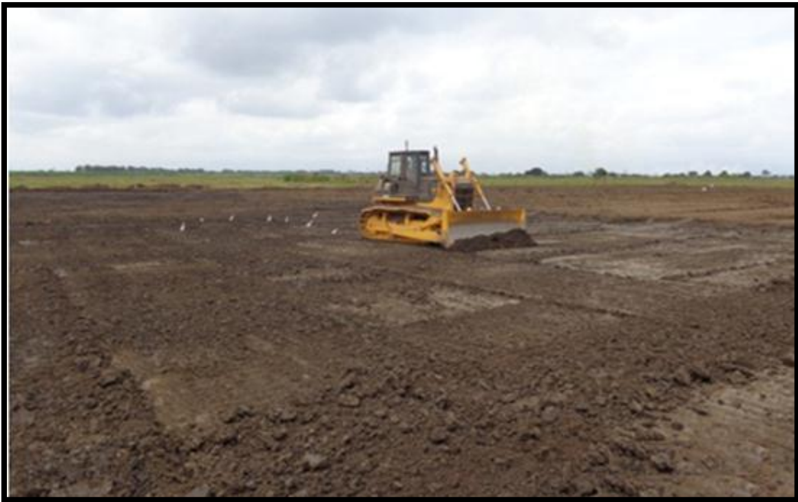
Fotografía 4. Conformación y preparación de la subrasante
