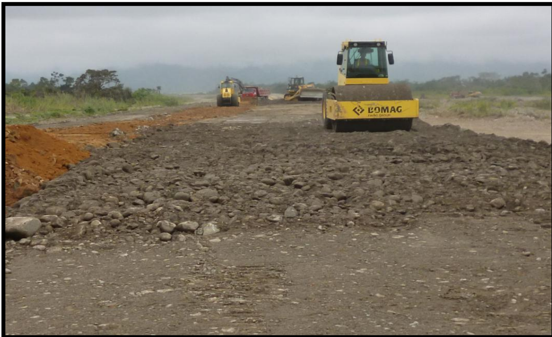
Fotografía 13. Material granular compactado con rodillo vibratorio liso, autopropulsado.
