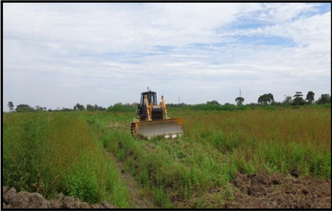
Fotografía 2. Desbroce, desbosque y limpieza
