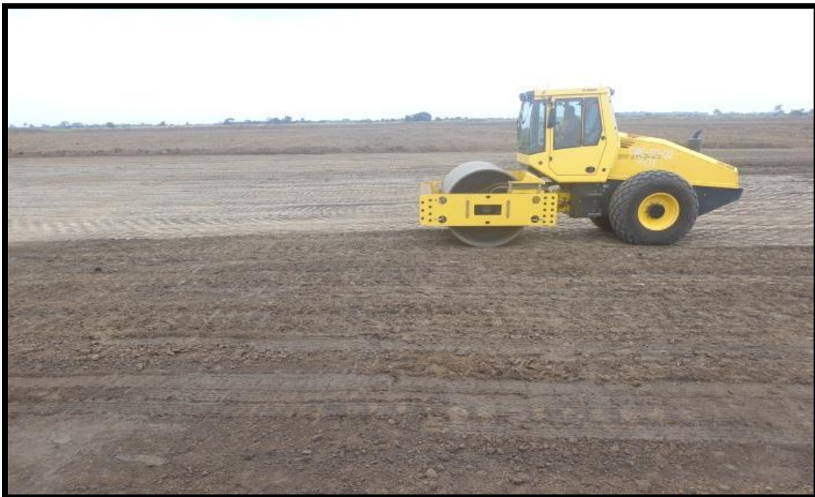
Fotografía 5. Compactación de la subrasante
