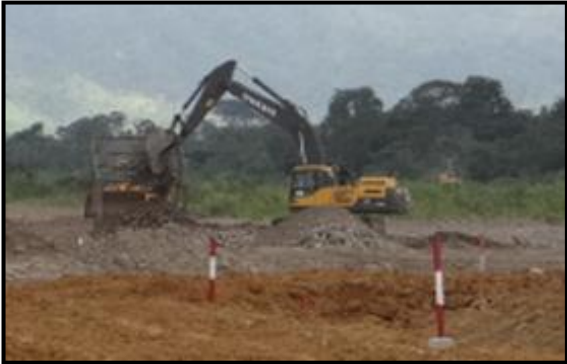
Fotografía 8. Cribado del material granular proveniente del río.
