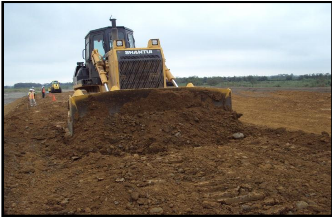
Fotografía 10. Colocación de materiales
