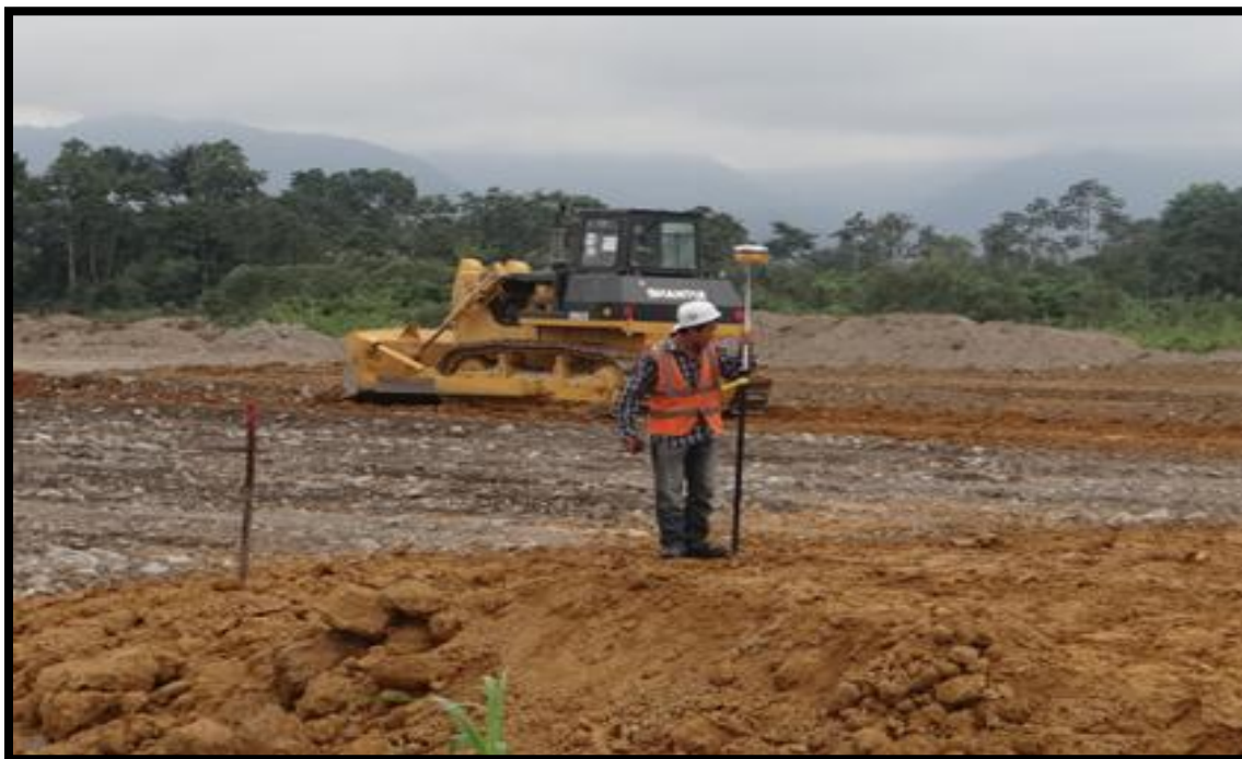
Fotografía 15. Verificación de cotas luego del colocado de cada capa.
