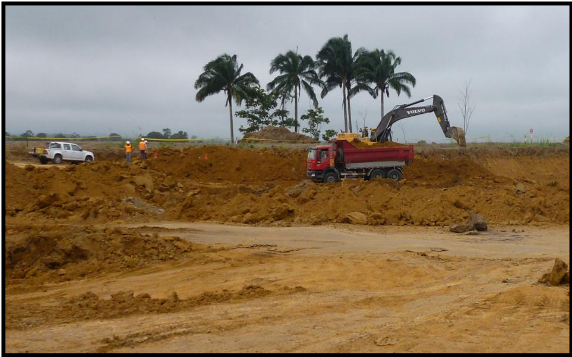
Fotografía 6. Excavación y obtención de arcilla en la mina.
