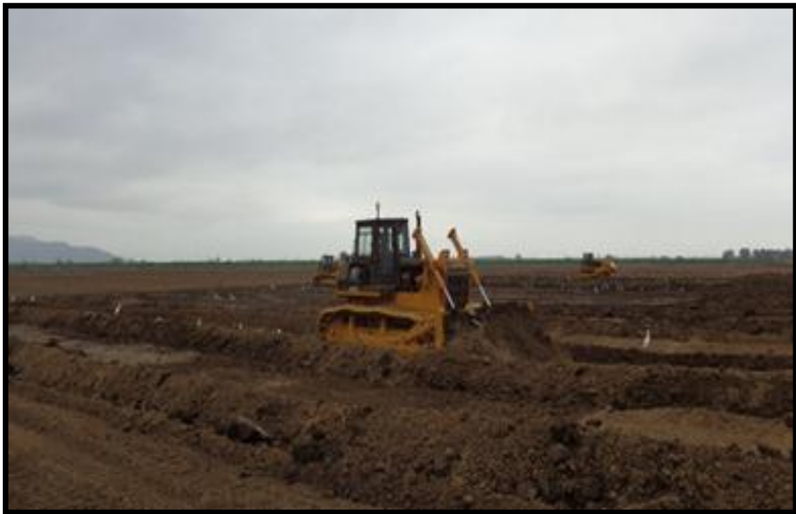
Fotografía 3. Retiro y acopio de la capa vegetal
