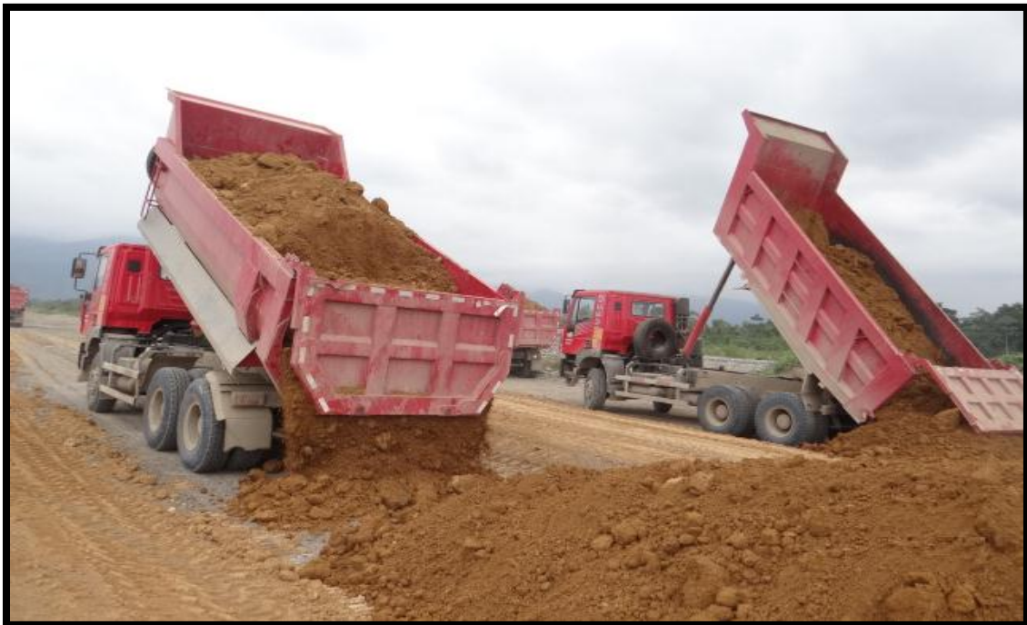
Fotografía 9. Colocación de materiales.
