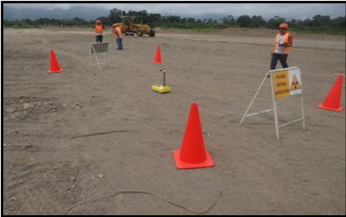
Fotografía 14. Comprobación del porcentaje de compactación y control de humedad.
