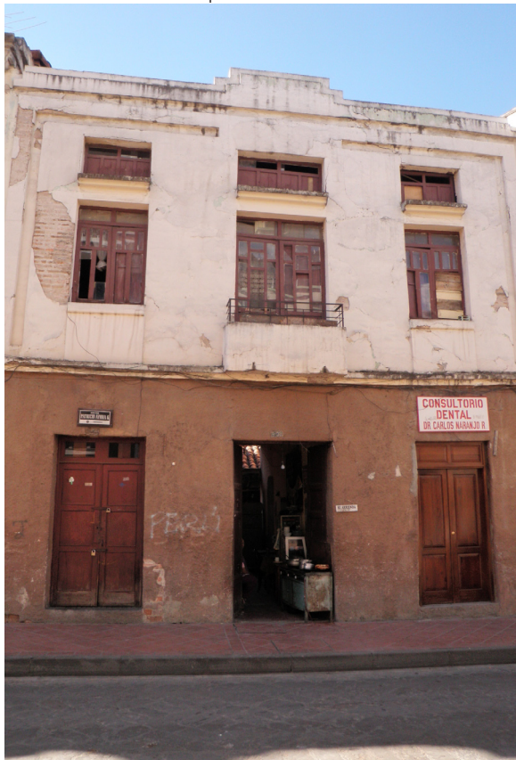
33 Vista a edificación patrimonial en la Juan Jaramillo
