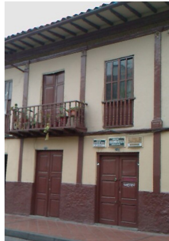
20 Vista a edificación patrimonial en la Juan Jaramillo
