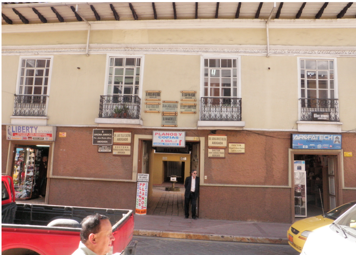
26, 27 Vista exterior e interior a la edificación patrimonial ubicada en la calle Presidente Cordova
