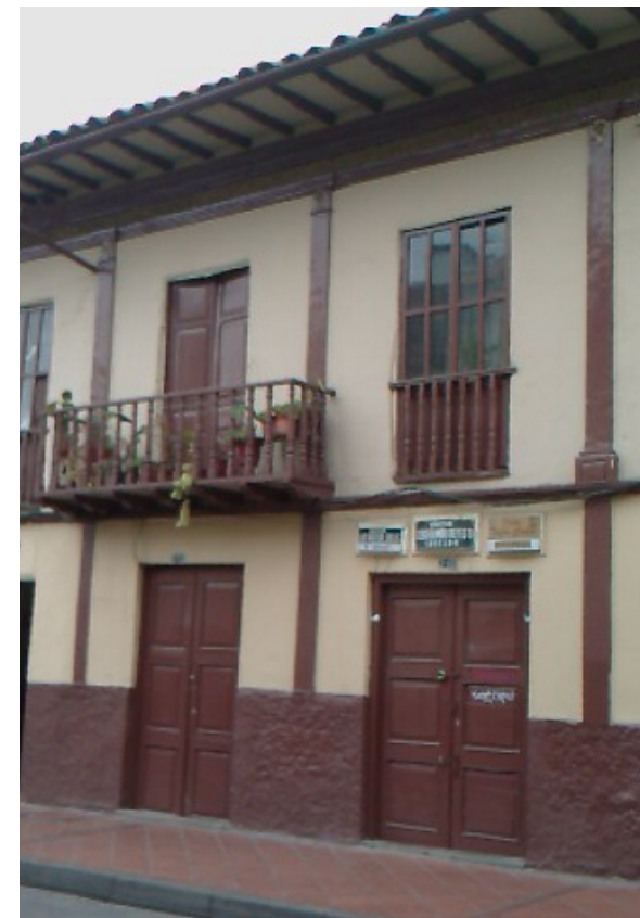
32 Vista a edificación patrimonial en la Juan Jaramillo
