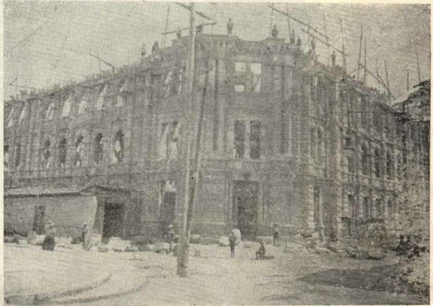
La Universidad en construcción
