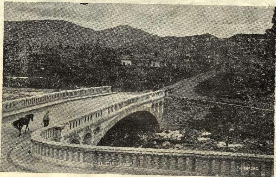
Puente "El Centenario"
