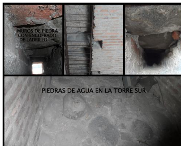
Ilustración 19: Muros de carga (piedra confinada con paredes de ladrillo)
