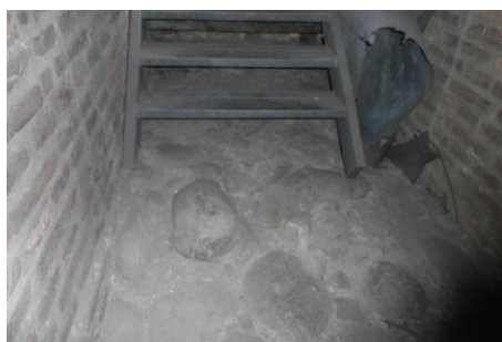
Ilustración 32: Gradas de acceso a la torre sur (hormigón ciclópeo)
