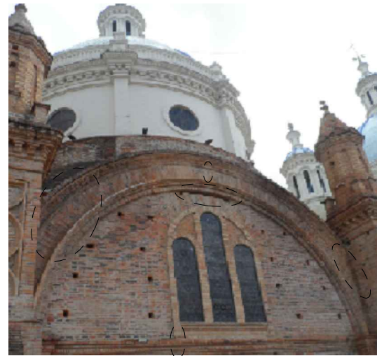
F39: FISURAS EN LA PARTE SUPERIOR E INFERIOR DE LA VENTANA
