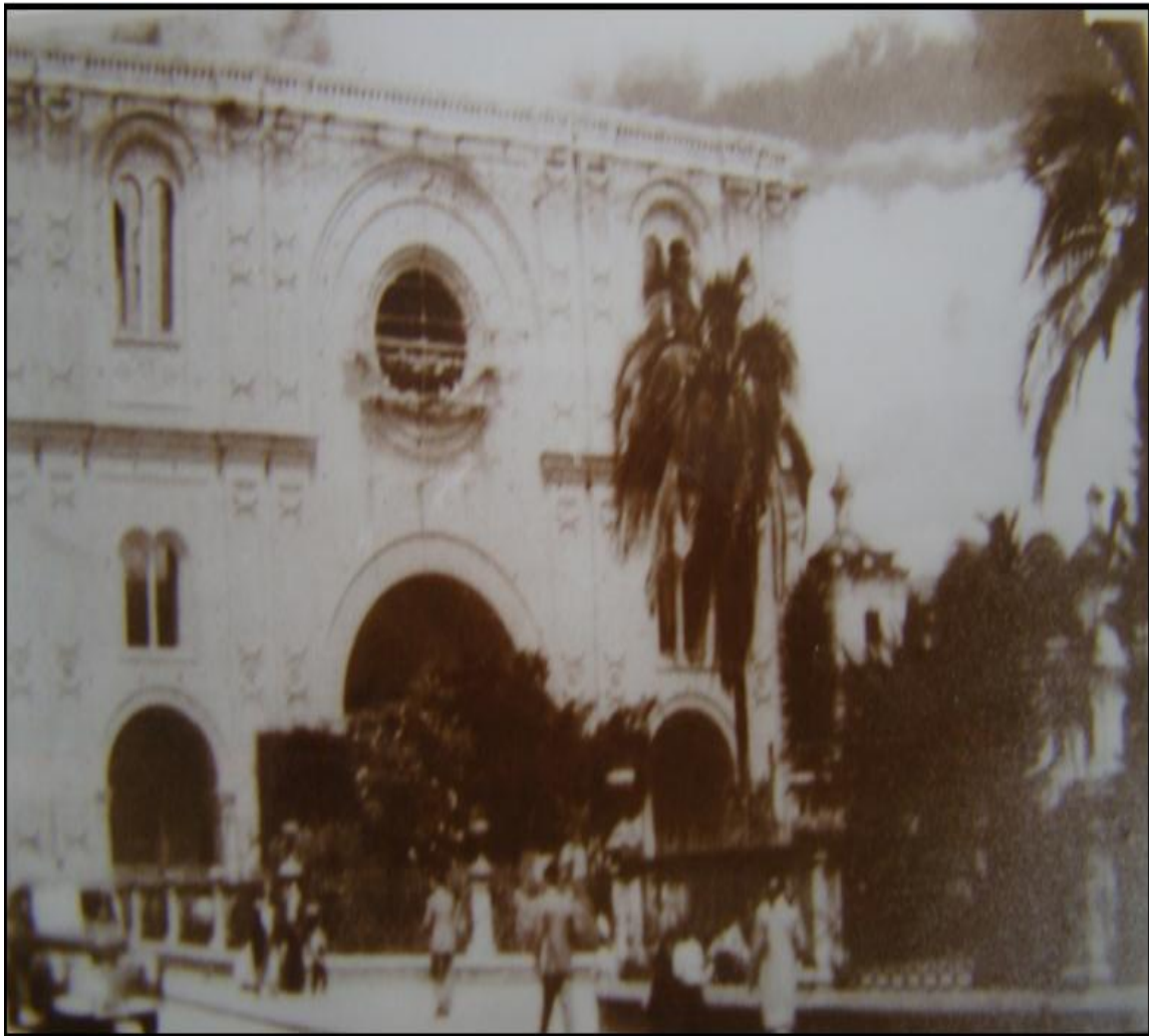
Ilustración 9: Catedral en construcción 1945. Fotografía publicada en Tesis de arquitectura
