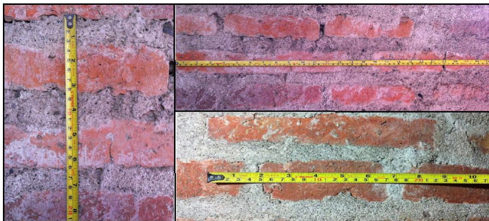
Ilustración 18: Espesor del mortero de cal
