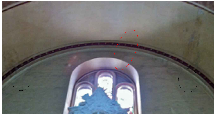
F23: FISURA EN EL ARCO DE LA VENTANA H31: HUMEDAD EN AMBOS EXTREMOS
