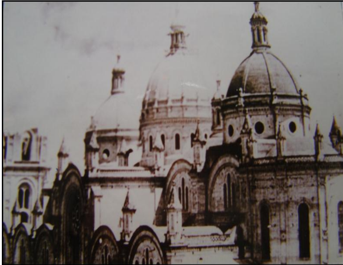
Ilustración 12: Catedral en construcción. 1950. Fotografía publicada en Tesis de arquitectura
