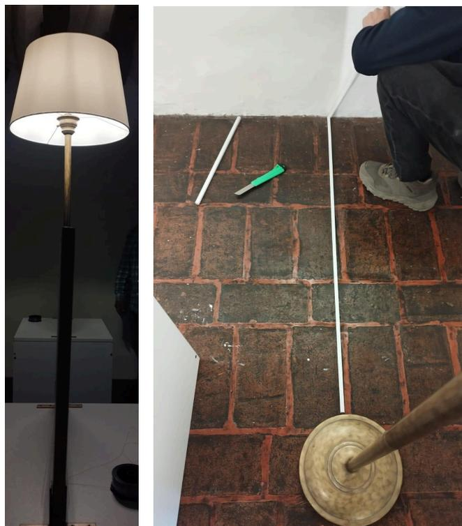
**Figura 24.** Búsqueda de simetría y colocación de canaleta para permitir el tránsito.
