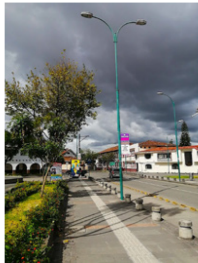
Fig 2. Av. Loja, sector de San Roque, contaminación visual en la vereda.
