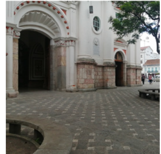
Fig 6. Puerta de entrada más transitada de la iglesia de San Francisco
