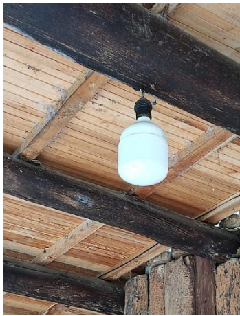
Ilustración 57 Foco led de alta intensidad 40 W
