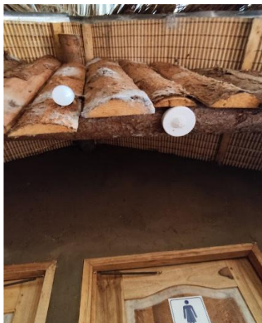
Ilustración 45 Sensor de movimiento
