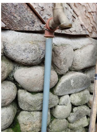
Ilustración 49 Fuga de agua en una llave Autor: Laura Valeria Galarza Medina y Lucía Aracely Márquez Guerrero Fuente: Propia
