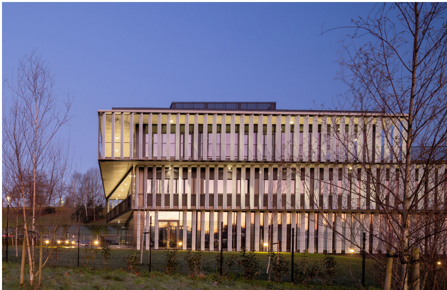
Figura 27: Edificio Fabrika (Biderbost Photo, 2023)
