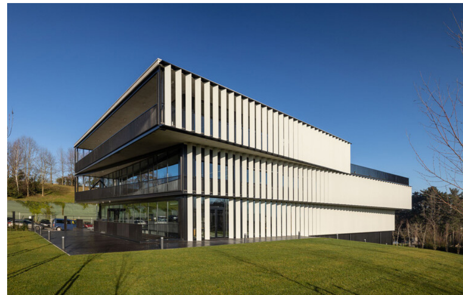
Figura 25: Edificio Fabrika (Biderbost Photo, 2023)
