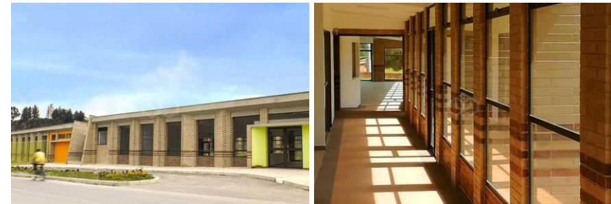
Figura 31. Ingreso del personal y el recorrido por los pasillos
