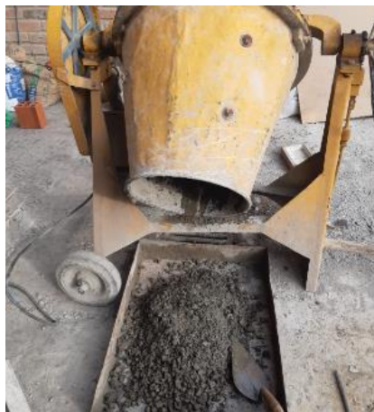
Figura 11. Preparación de la mezcla de hormigón.
