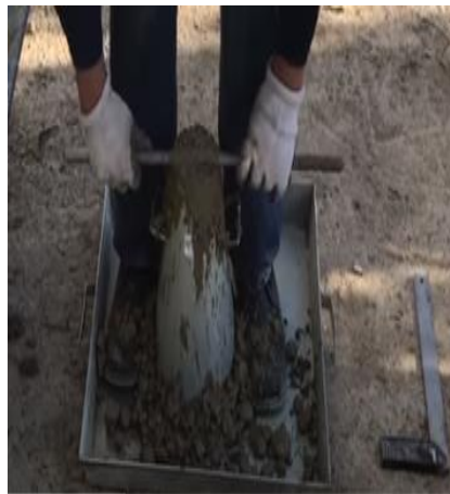
Figura 18. Enrasado de la muestra, (Tecnología del Hormigón UCB, 2017).
