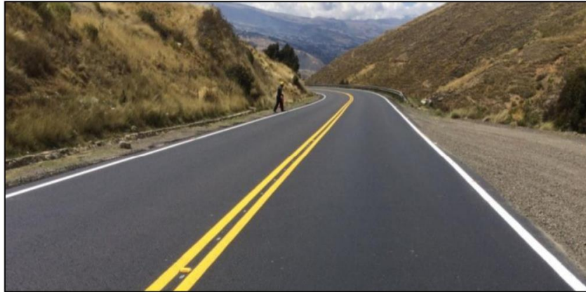
Figura 2. Ejemplo de un pavimento flexible.
