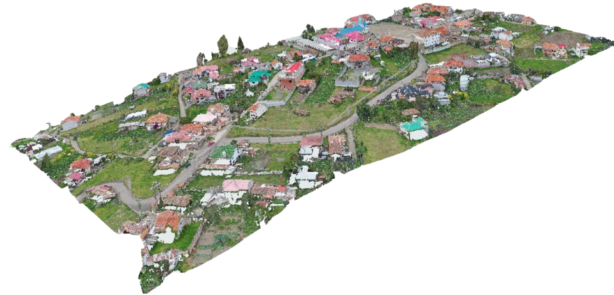
Figura 91. Levantamiento de dron área específica de estudio Fuente: Elaboración propia
