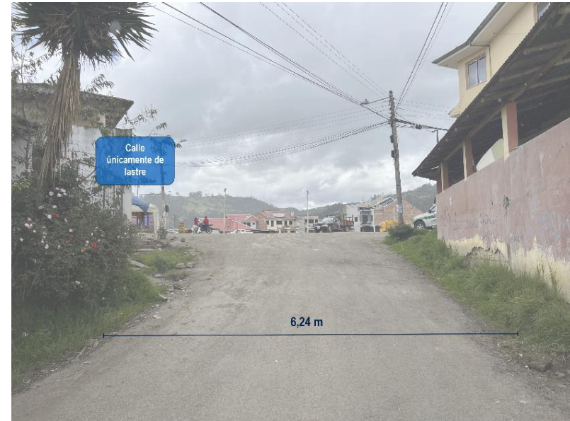
Figura 109. Entrada a la plaza por Camino a Narancay Fuente: Elaboración propia
