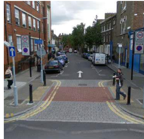
Figura 57. Puertas de entradas Fuente: MSVE (2020)
