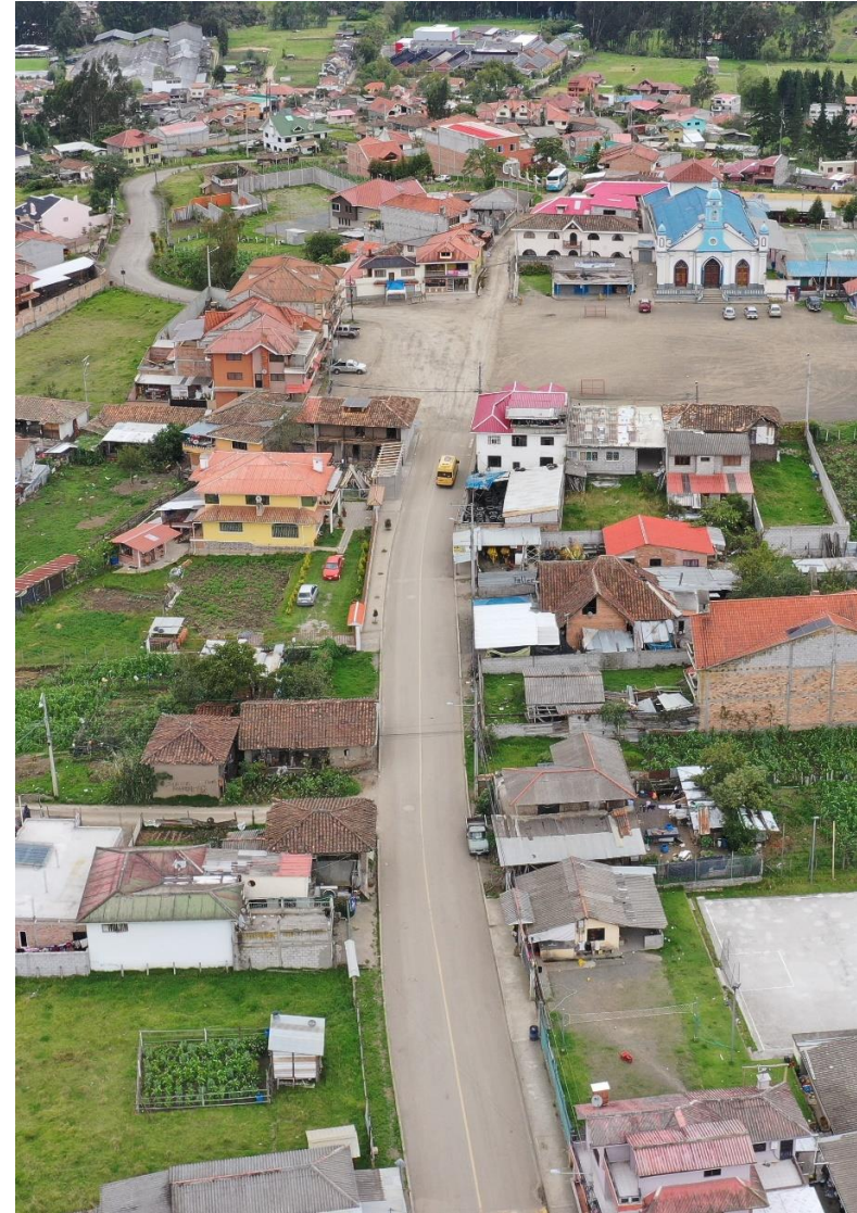
Figura 94. Camino a Narancay- Baños Fuente: Elaboración propia
