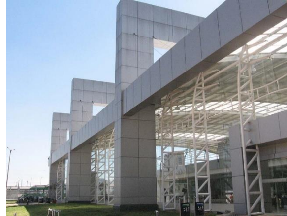
Figura 57. Estructura de fachada de la Terminal Terrestre Quitumbe.
