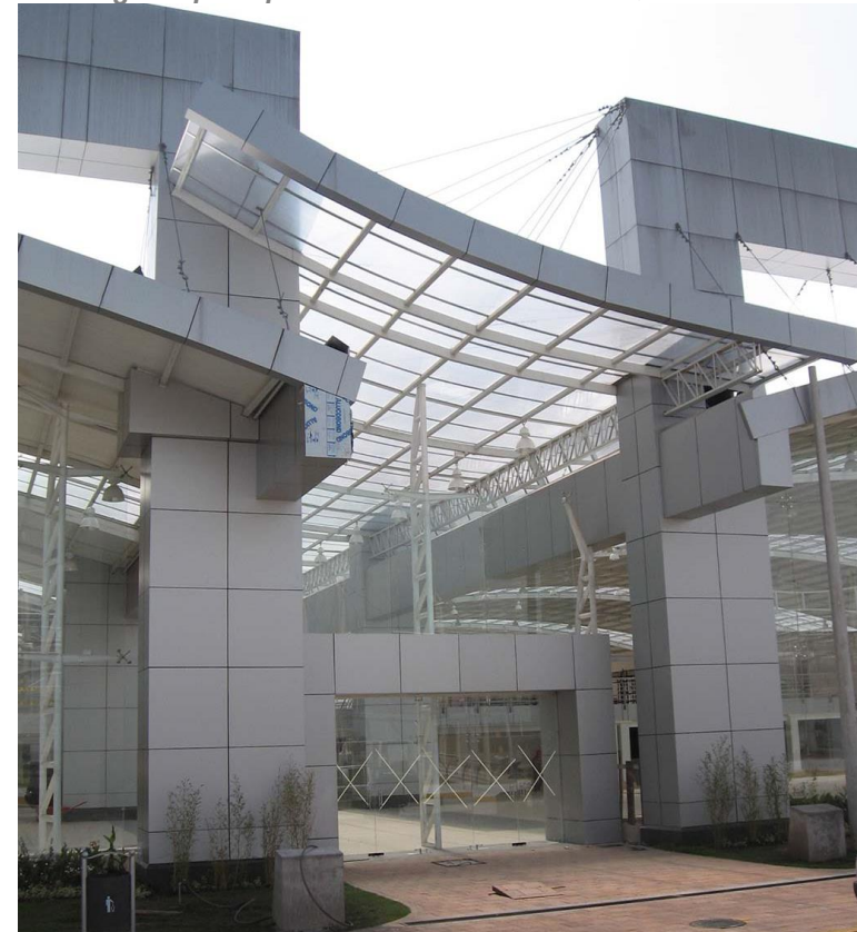
Figura 55. Ingreso principal de la Terminal Terrestre Quitumbe.
