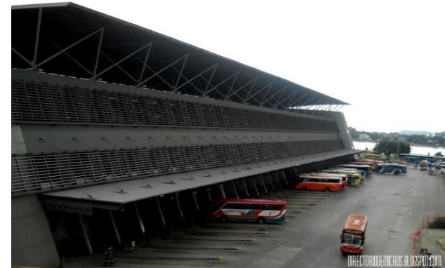
Figura 47. Andenes de arribo de la Terminal Terrestre de Guayaquil.
