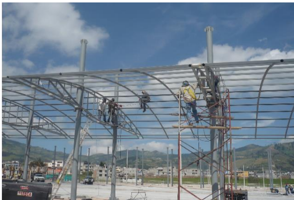
Figura 56. Armado de estructura de cubierta de la Terminal Terrestre Quitumbe.
