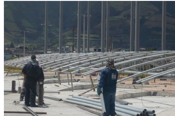
Figura 58. Estructura de cubierta de la Terminal Terrestre Quitumbe.
