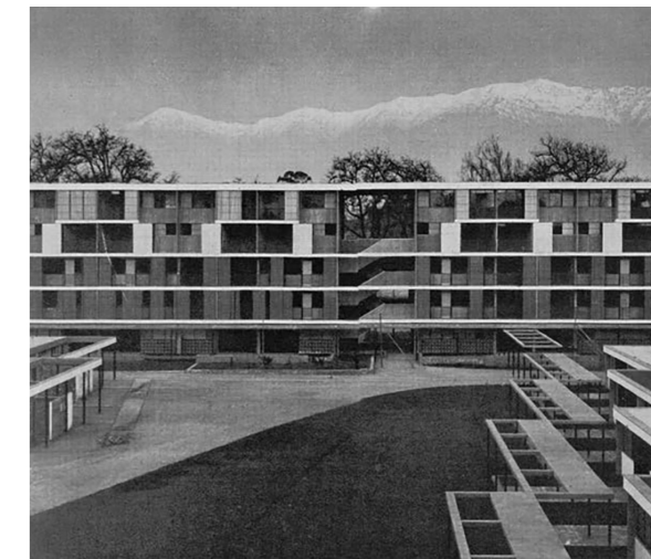
Figura 2. Unidad Vecinal Portales, Santiago de Chile. Fuente: Chacón, G.
