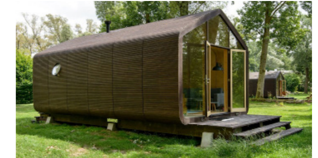
Figura 99. Casa Wikkelhouse Fuente: Shen, Y
