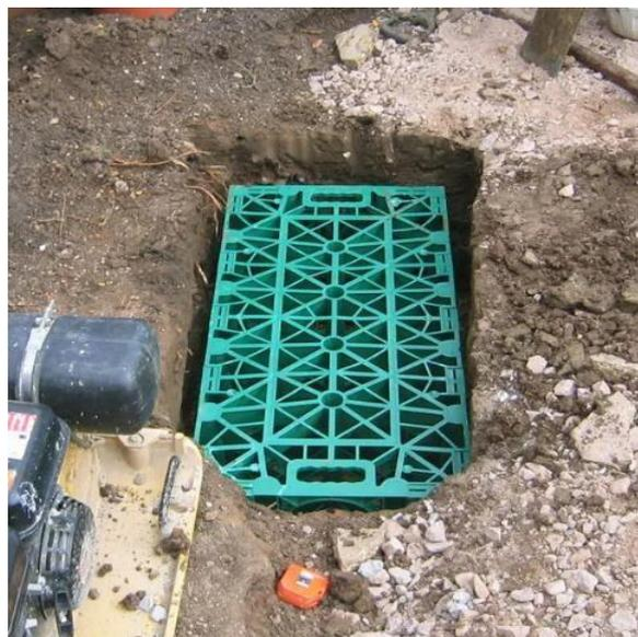
Figura 36. Pozo de infiltración con elemento modular. Fuente: (Abellán, 2016b)
