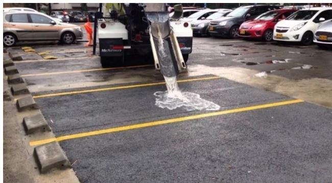
Figura 40. Pavimento permeable mediante asfalto poroso. Fuente: (AsfaltosUnico, 2018)
