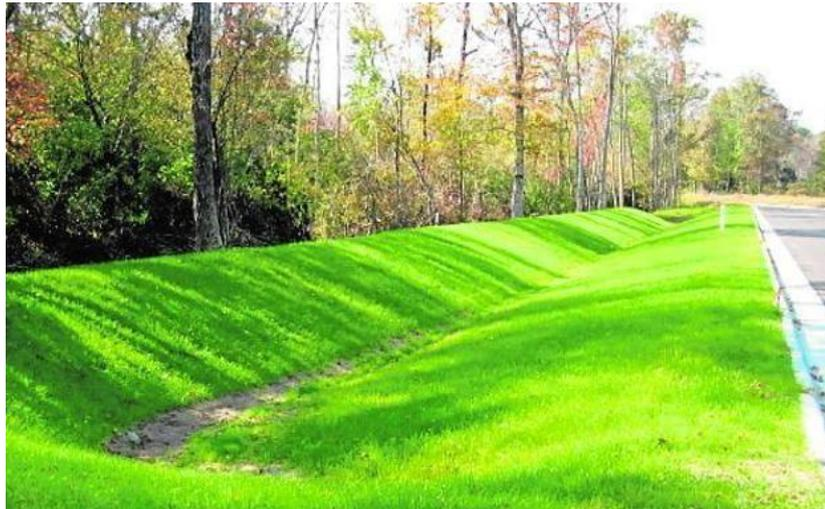
Figura 42. Sistema de drenaje de autopista mediante cuenta verde. Fuente: (Navarro, 2018)
