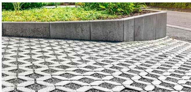
Figura 41. Pavimento permeable mediante bloques modulares. Fuente: (EXPOCIHAC, 2023)
