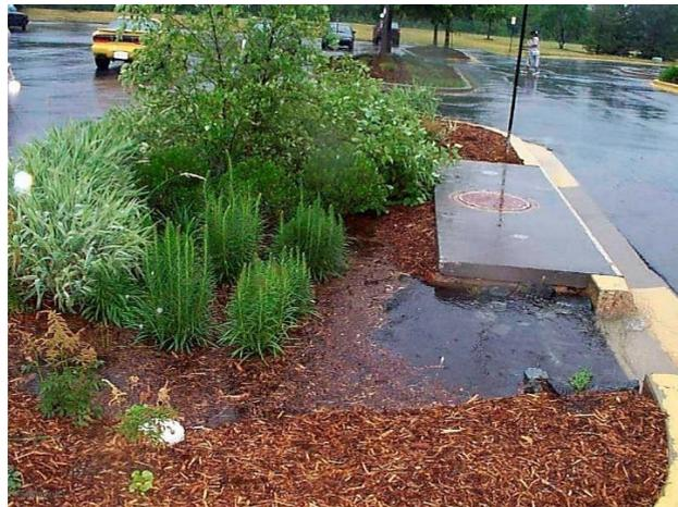
Figura 39. Sistema de bioretención ubicado en estacionamientos. Fuente: (Agencia Iberoamericana para la difusión de la ciencia y la tecnología, 2016)
