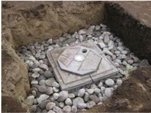
Figura 35. Pozo de infiltración rodeado de relleno granular. Fuente: (Quiroz & Becerra, 2018)
