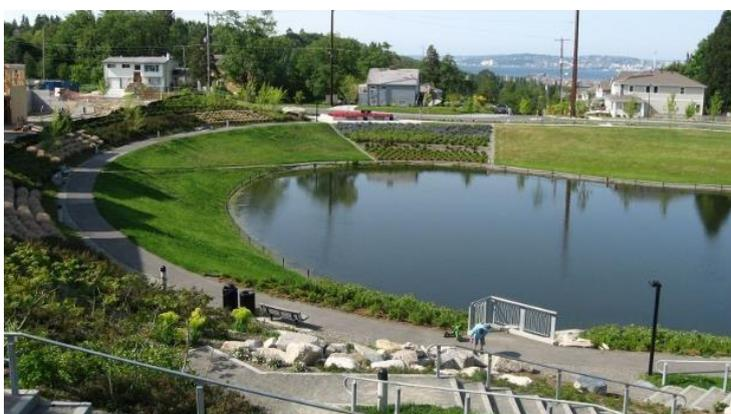
Figura 38. Depósito de retención. Fuente: (Abellán, 2016a)
