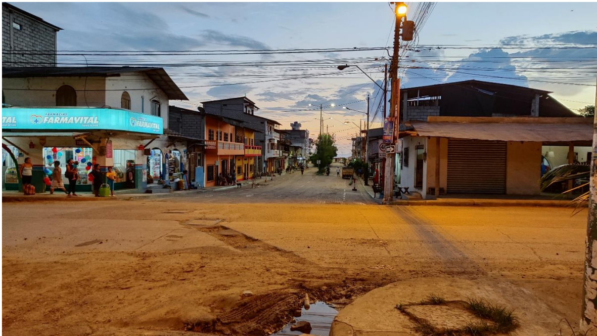
Nota. Estado actual de la vía Ruta del Spondylus y la calle Luis Rosales de Montañita.
