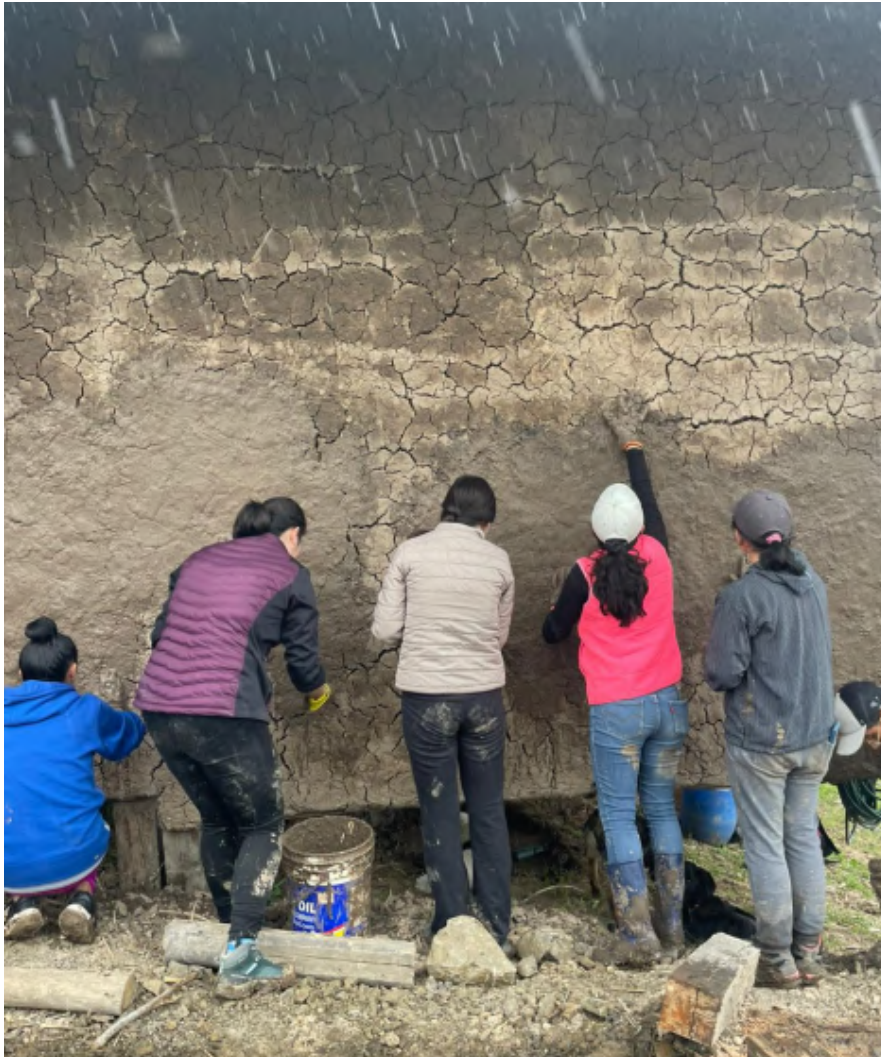
Figura 4.7.2 Participación en el taller de bioconstrucción Técnica de bahareque
