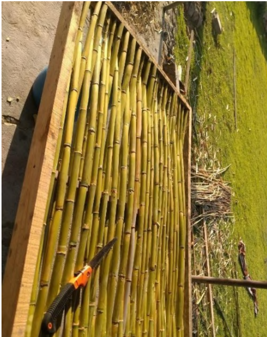
Figura 4.7.1 Vista del entramado de carrizo
