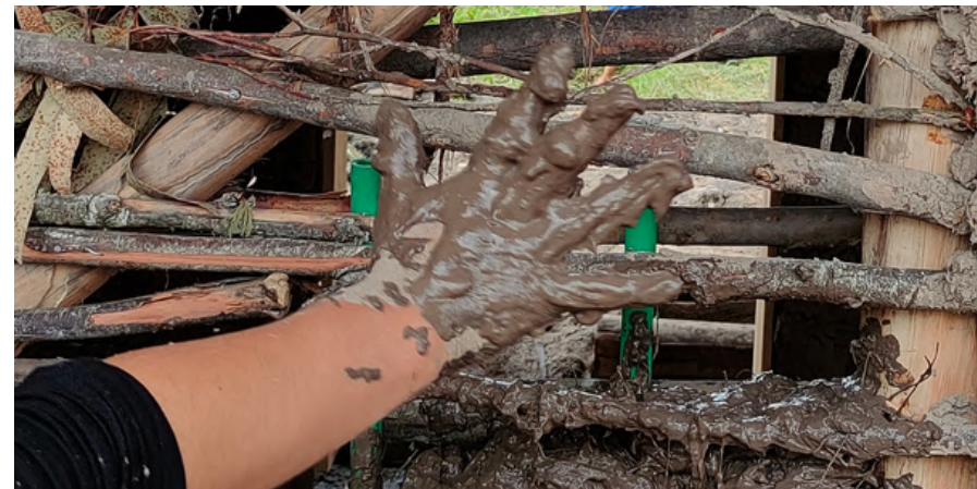
Figura 4.7.4 Colocación del revoque en la estructura de bahareque
