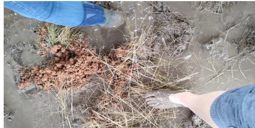
Figura 4.7.3 Preparación del revoque
