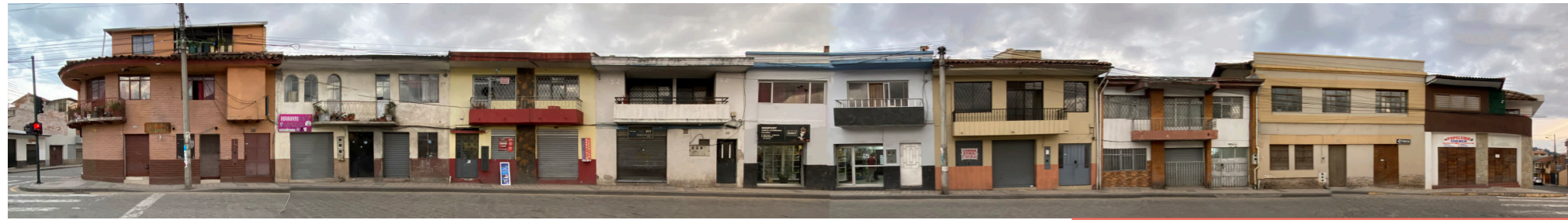
Figura 135 Levantamiento de tramo calle Manuel Vega
