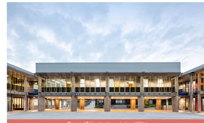
Figura 68 Fachada aularios UEPM
