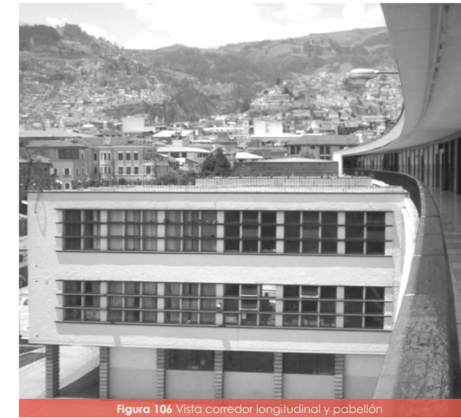
Figura 106 Vista corredor longitudinal y pabellón
