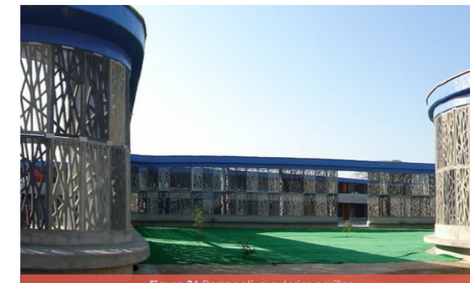
Figura 36 Perspectiva exterior pasillos
