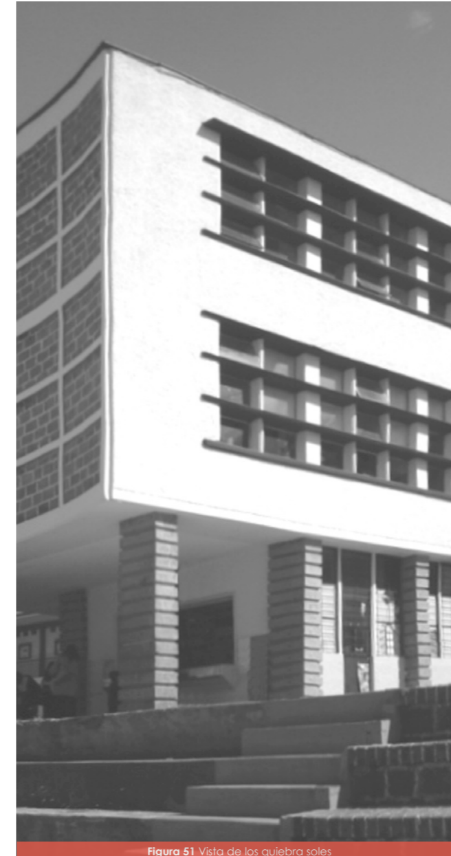
Figura 51 Vista de los quebra soles
