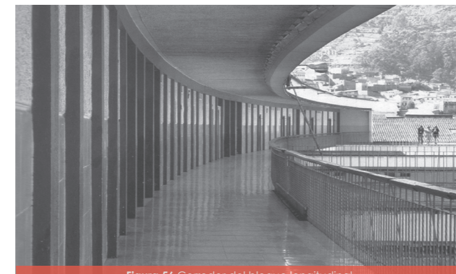
Figura 56 Corredor del bloque longitudinal
