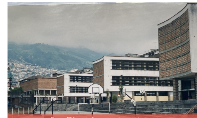
Figura 57 Escuela Sucre canchas y pabellones
