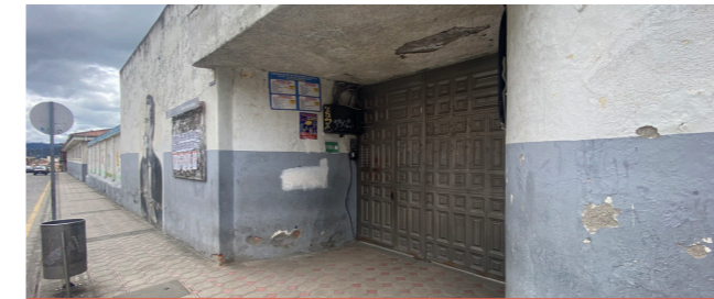
Figura 142 Ingreso y salida 1
