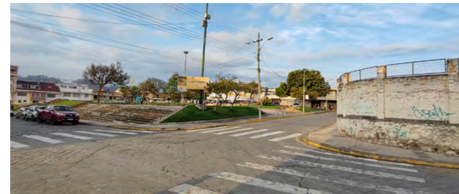
Fig.52. Estado Actual Escuela Luis Cordero 05 Elaboración: Propia
