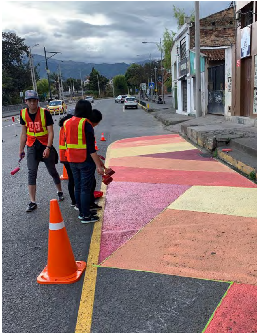
Fig.19. Aplicación de pintura en zonas peatonales Fuente: Pineda & Cardoso, 2020
