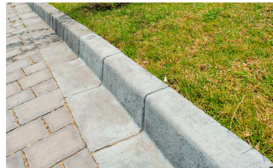
Fig.229. Hormigón prefabricado para bordillos
