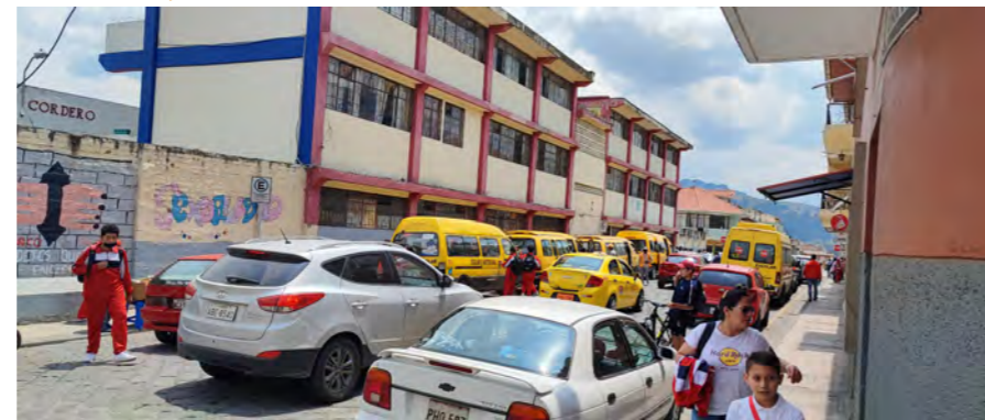
Fig.46. Estado Actual Escuela Luis Cordero 02 Elaboración: Propia
