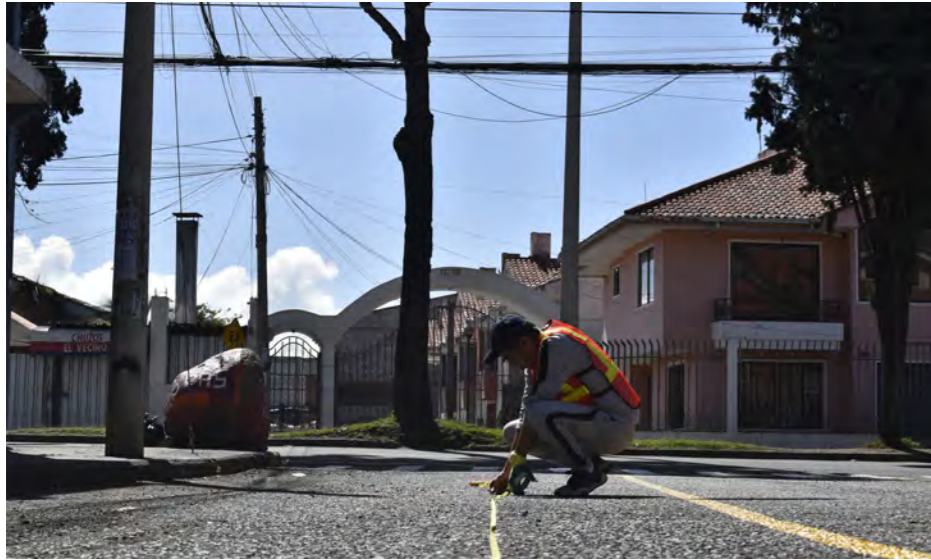
Fig.182. Trazado en calzada del diseño Fuente: Propia
