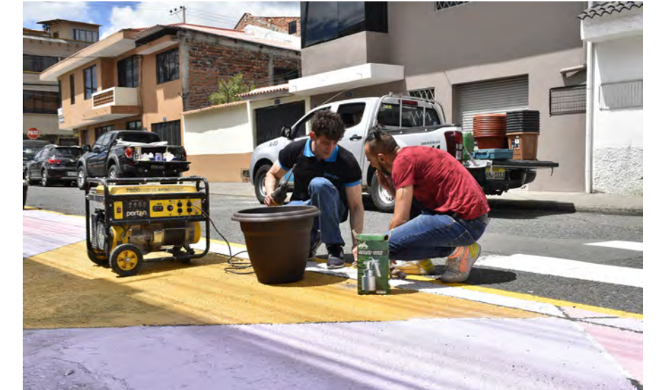
Fig.180. Colocación de macetas Fuente: Propia
