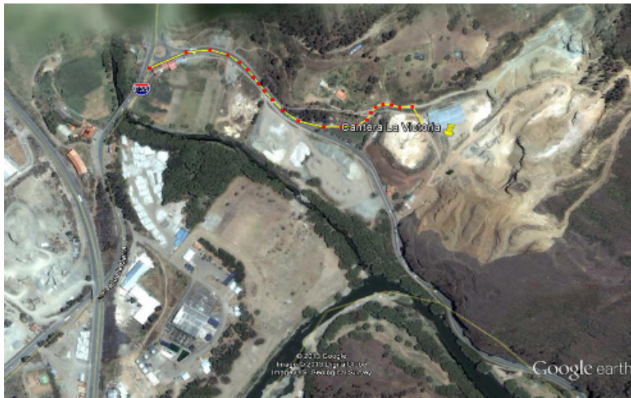
Figura 2.2.: Acceso a la cantera “Las Victorias” (Google Earth, 2013).
