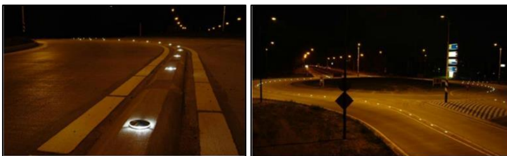
Ilustración 17 Iluminación de una turbo rotonda, (Ministry of Transport, Public Works and Water Management, 2009)
