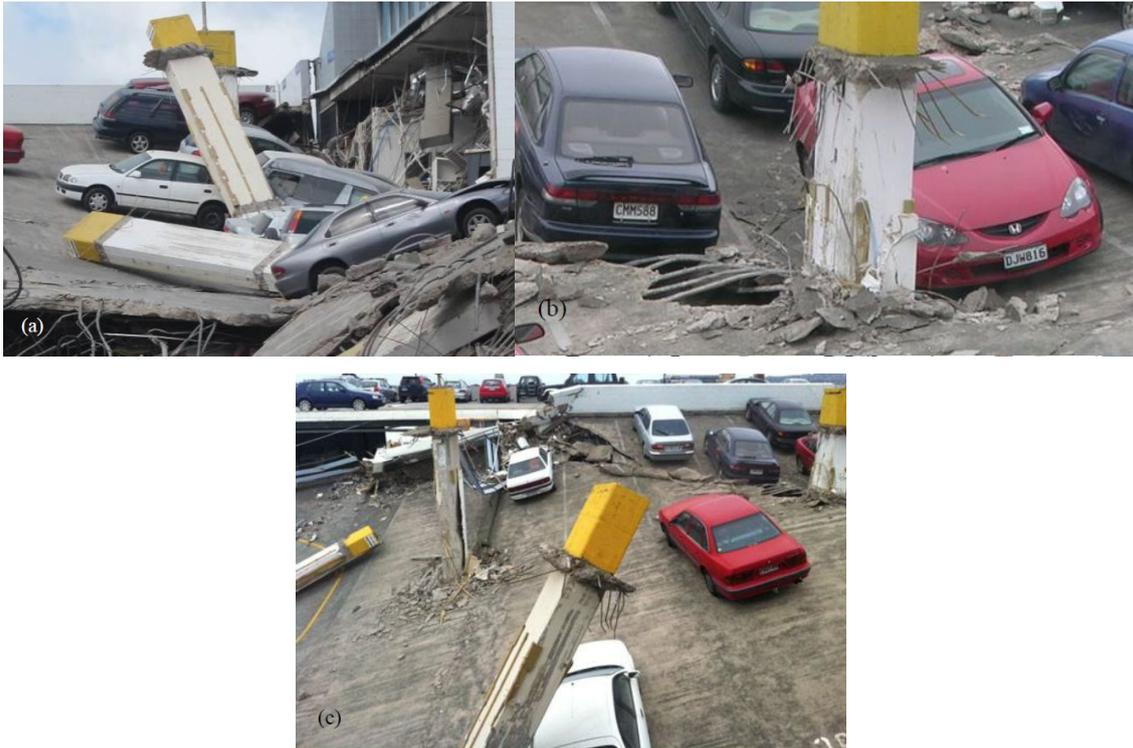
*Figura 2-2. Falla por punzonamiento en un estacionamiento de 5 pisos en Christchurch (Kam et al. 2011)*
