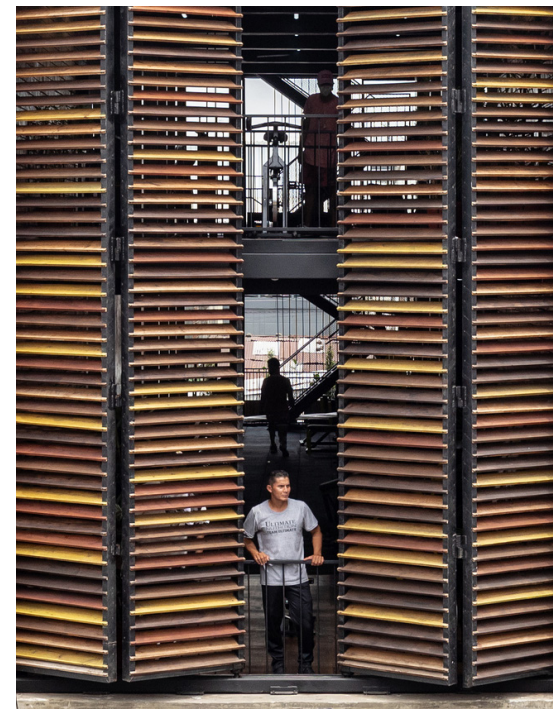
Figura 106: Sistema de celosías Fuente: Bardales gimnasio urbano, 2020
