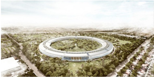
Figura 17: Tendencias Futuras de oficinas Fuente: Archdaily, 2011
