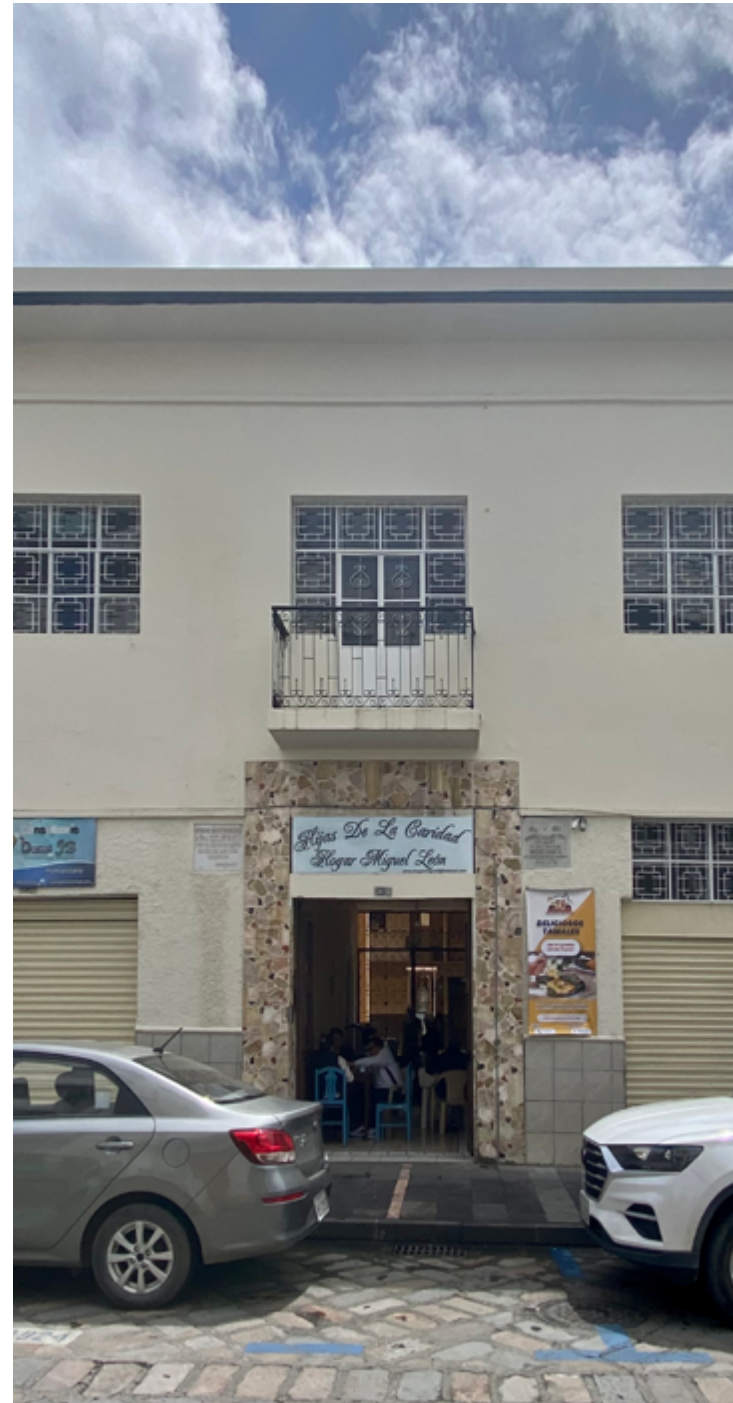
Figura 47 Fachada principal del Hogar Miguel León
