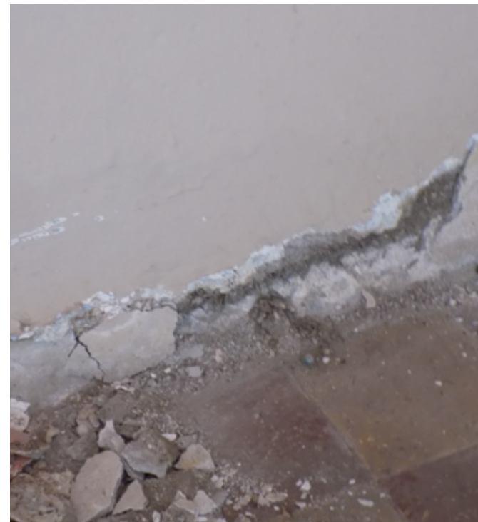
Figura 105 Desprendimiento de muros
