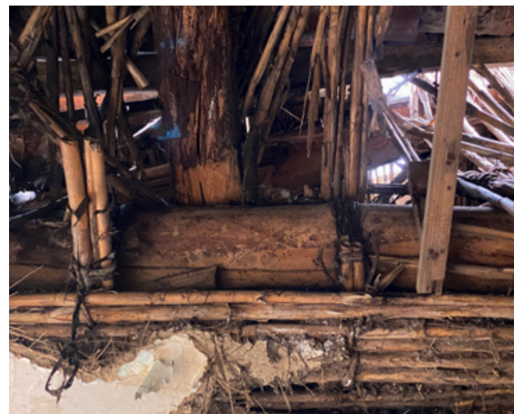
Figura 96 Amarrado con penco en elementos de cubierta
