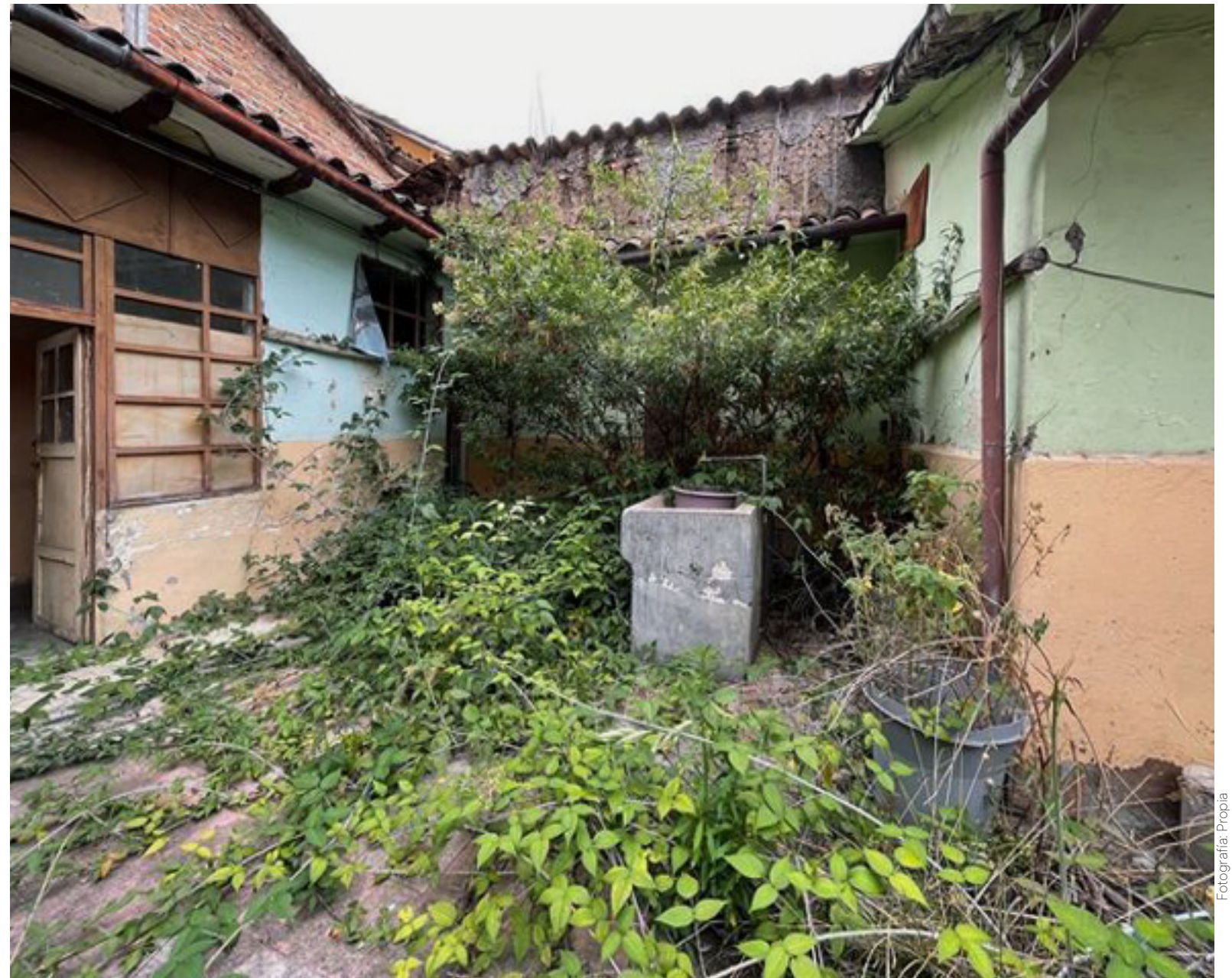
Figura 77 Patio del bloque A01
