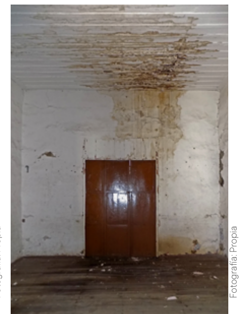
Figura 71 Presencia de humedad
