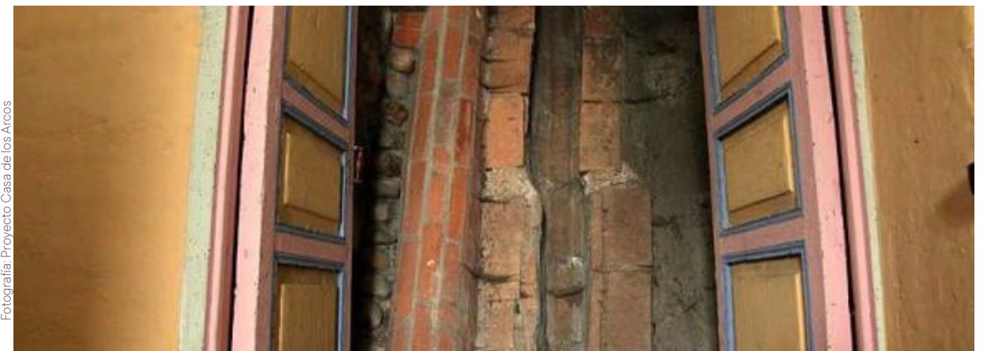
Figura 26 Canal de ladrillo
