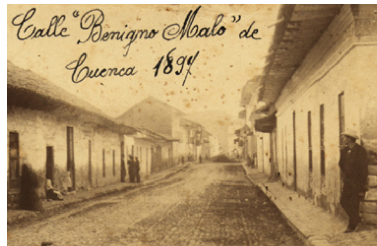
Figura 97 Viviendas en color blanco con la parte baja manchada
