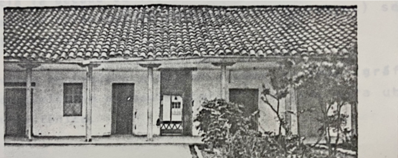
Figura 54 Crujía central demolida en 1978
