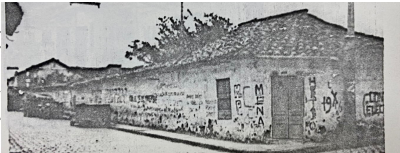
Figura 55 Muro de adobe demolido en 1982
