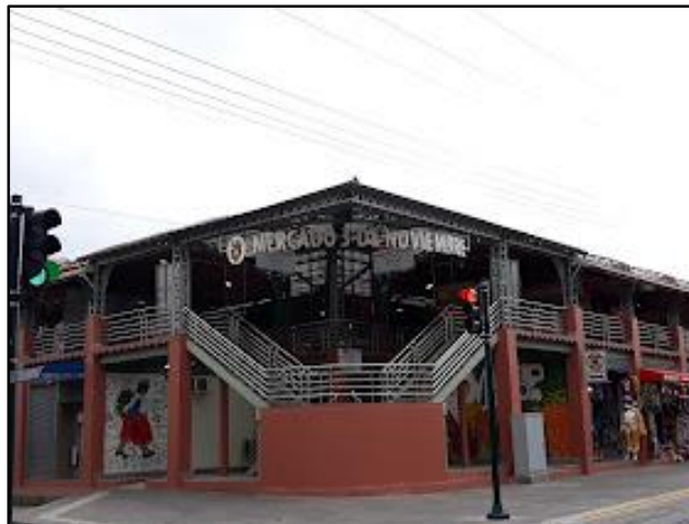
Imagen 8: Área por m2 del mercado 3 de Noviembre
