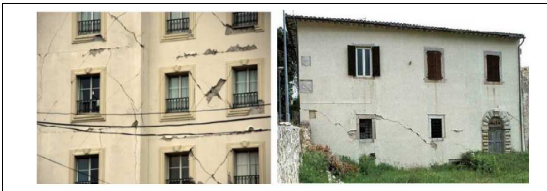
Figura 16 Mecanismos de falla en el plano. Fuente: Tomado de Manzi (2017).
