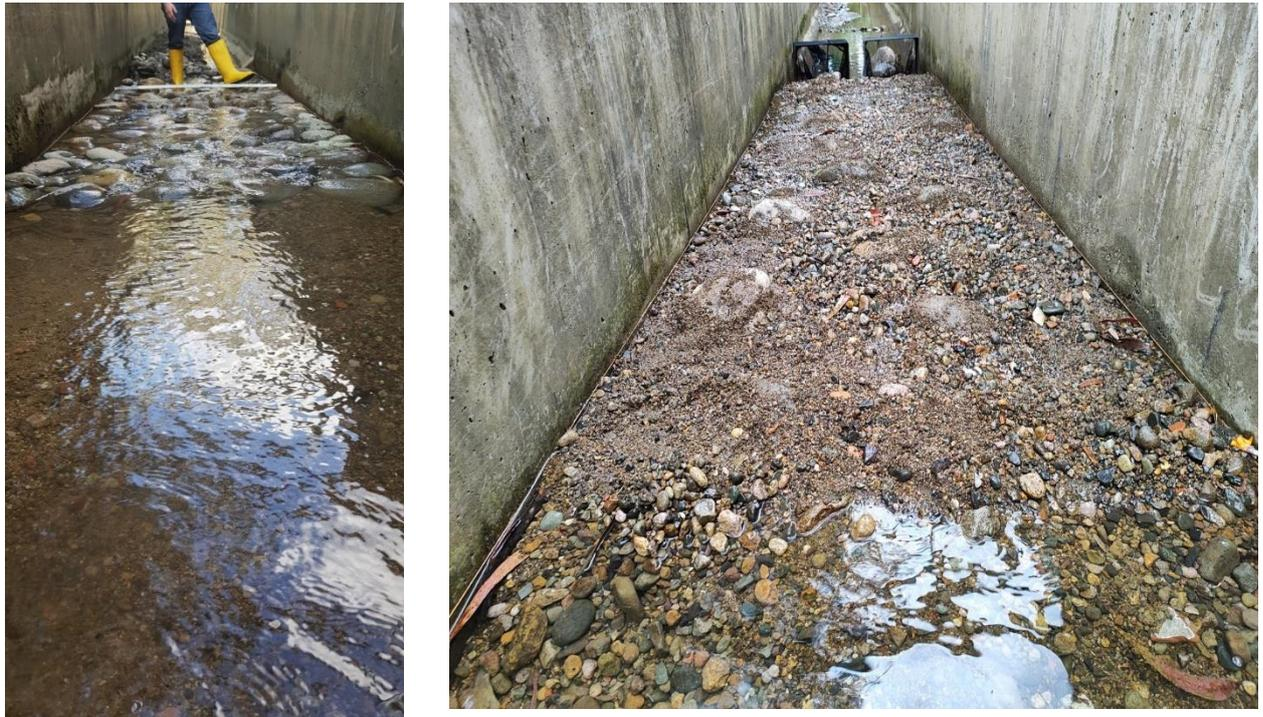
**Figura 24.** Conformación de capa de lecho móvil
