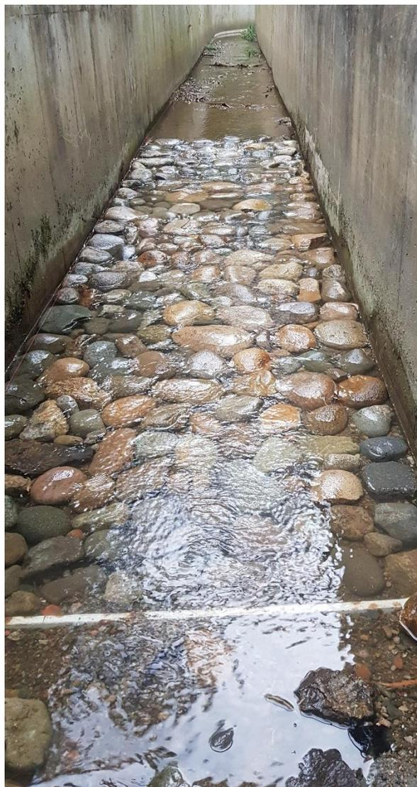
**Figura 10.** Capa de lecho móvil conformada
