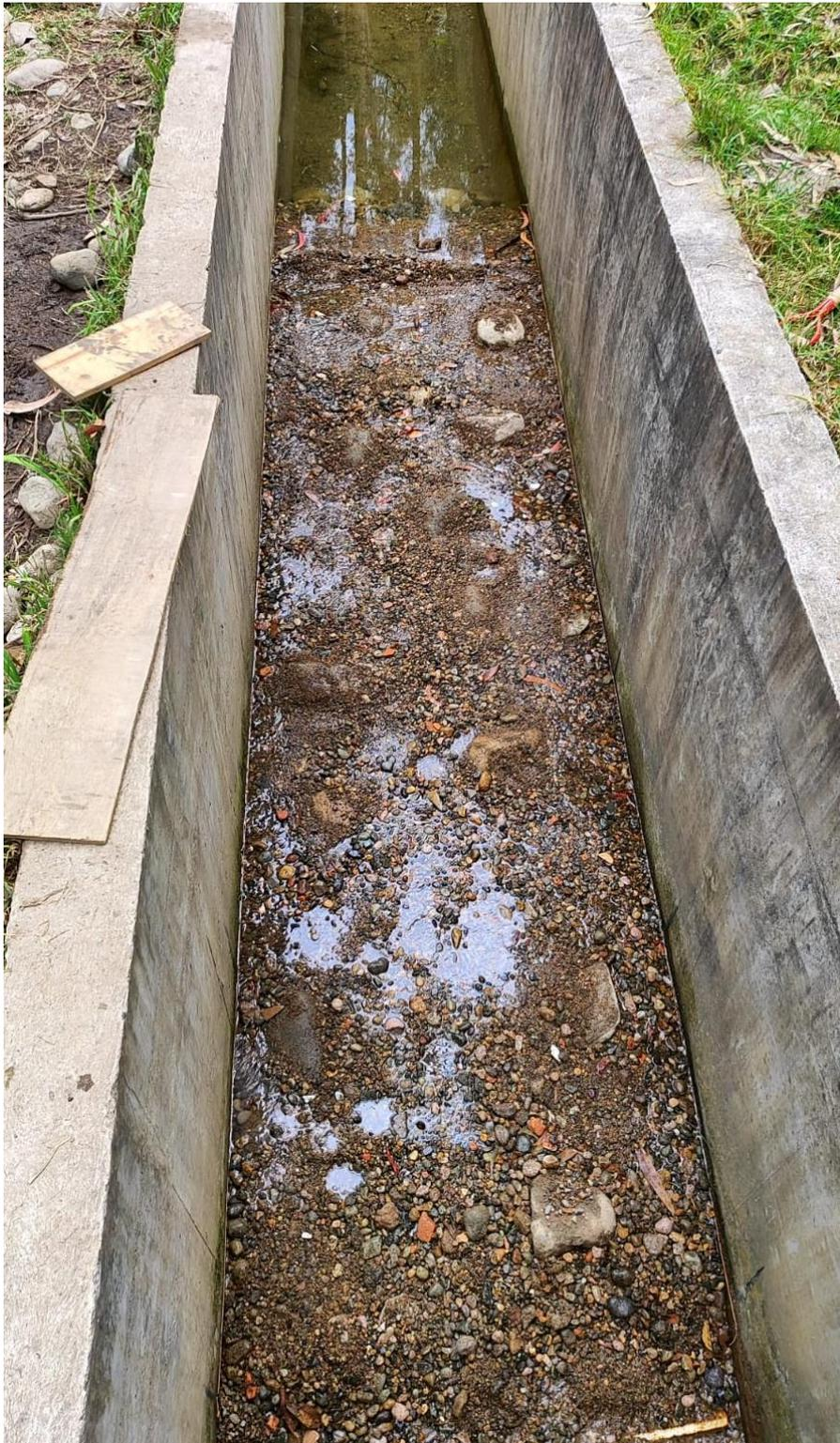
**Figura 14.** Capa de lecho móvil conformada
