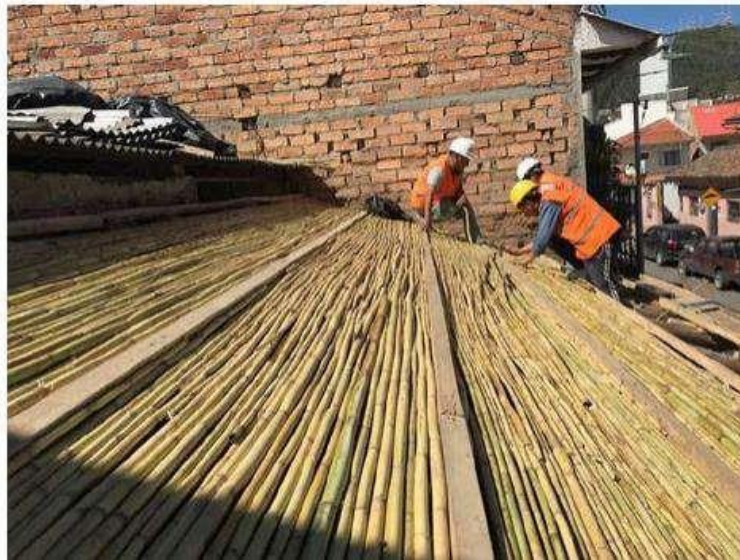
Figura 12. Incorporación de carrizo en cubierta sobre estructura de madera. Elaboración: Proyecto VliirCPM 2023.
