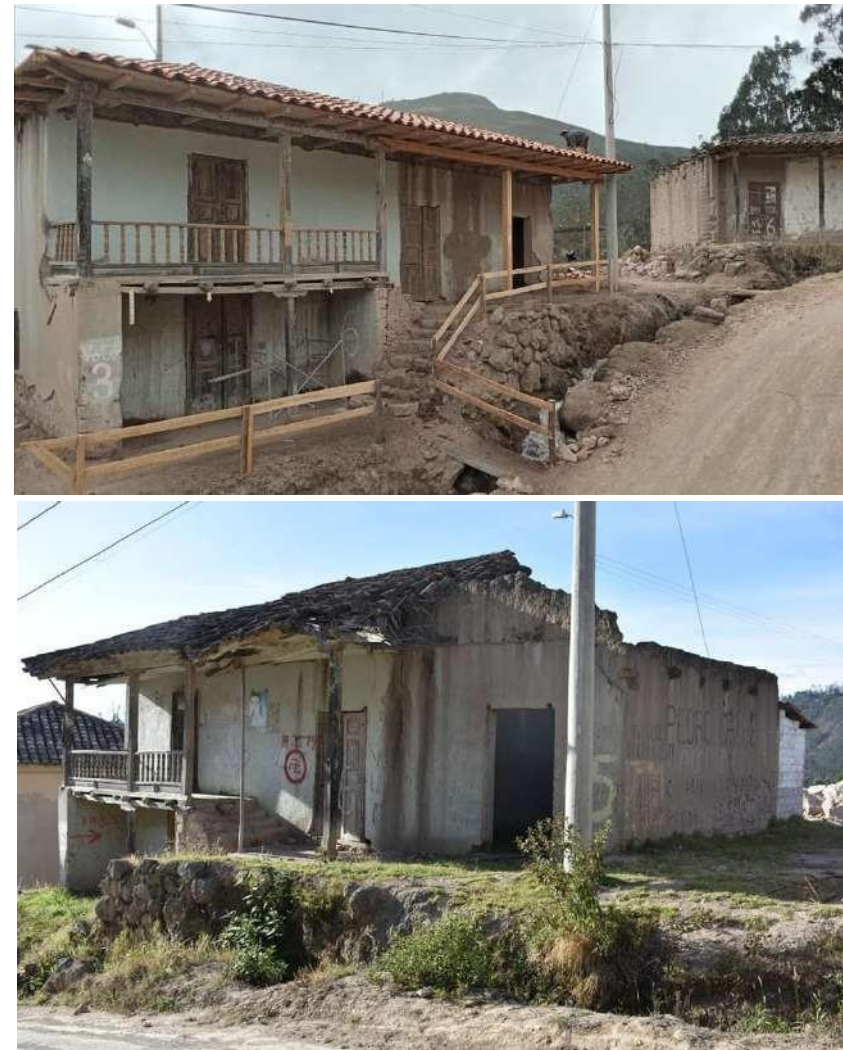
Figura 13. Edificación antes y después de la intervención. Elaboración: GAD municipal del cantón de San Felipe de Oña (2021).
