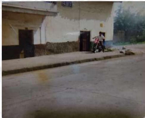
Figura 25 Vivienda que tuvo un colapso estructural de vivienda debido a obras públicas en el tramo patrimonial de la Av. Loja Elaboración: Recopilación de fotos de Mónica Vanegas.
