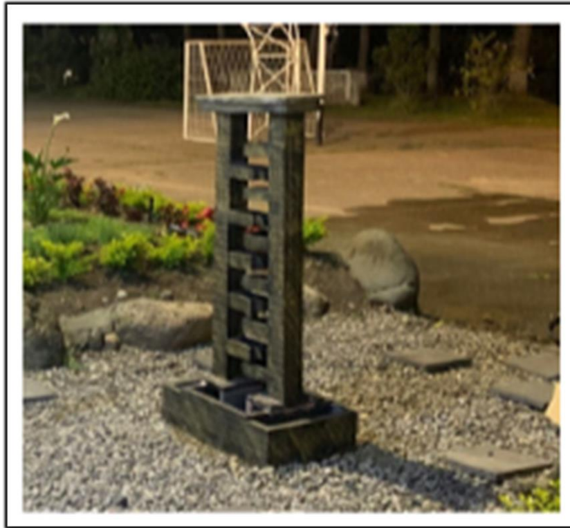
Figura 20. Instalación de la fuente de agua.
