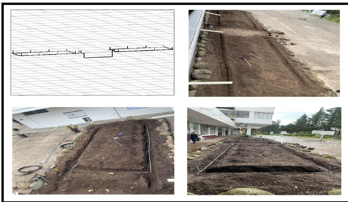
Figura 17. Instalación de riego: Diseño en AutoCAD, Cavado de zanjas e Instalación de tuberías.
