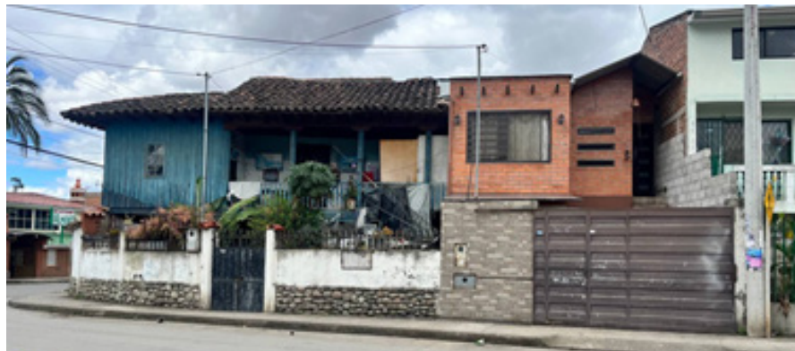
Figura 18. La edificación de interés patrimonial ya no existe, se observa una edificación de dos pisos, de ladrillo en su lugar.
