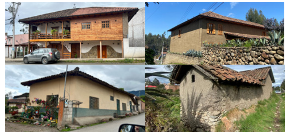
Figura 19. Ejemplo de edificaciones en buen estado
