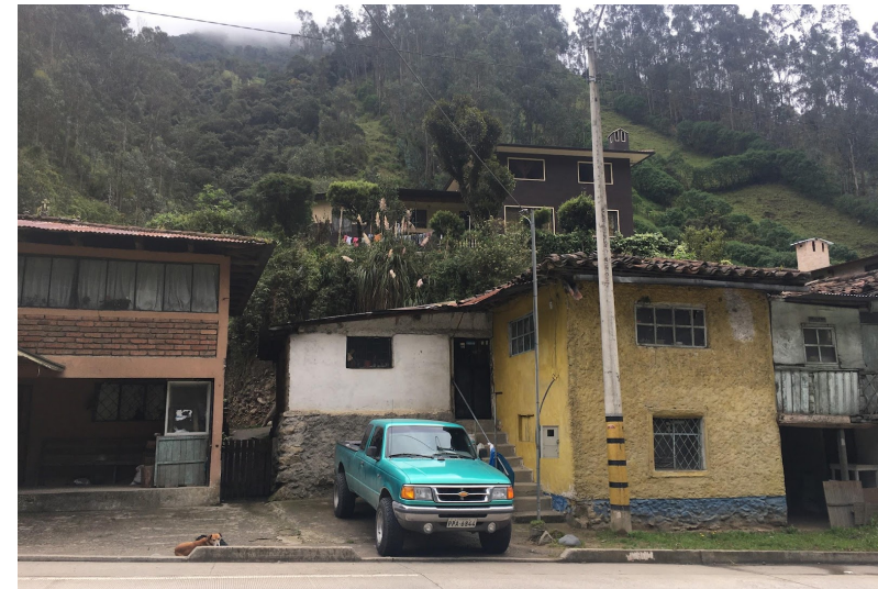
Figura 25. Edificaciones ubicadas en la pendiente
