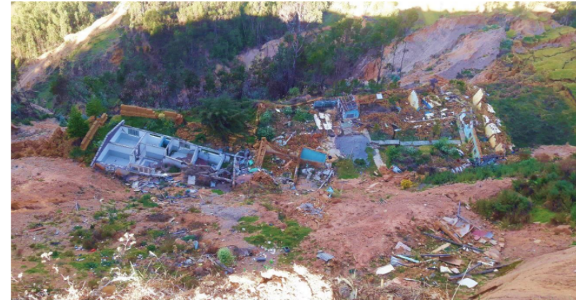
Figura 3. Zona afectada dentro de la comunidad de Sillapata
