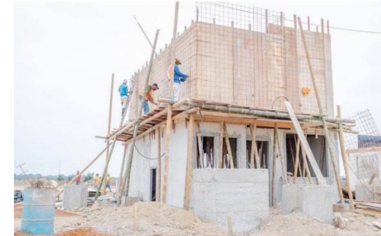
Figura 6 Construcción del modelo de vivienda ADRY
