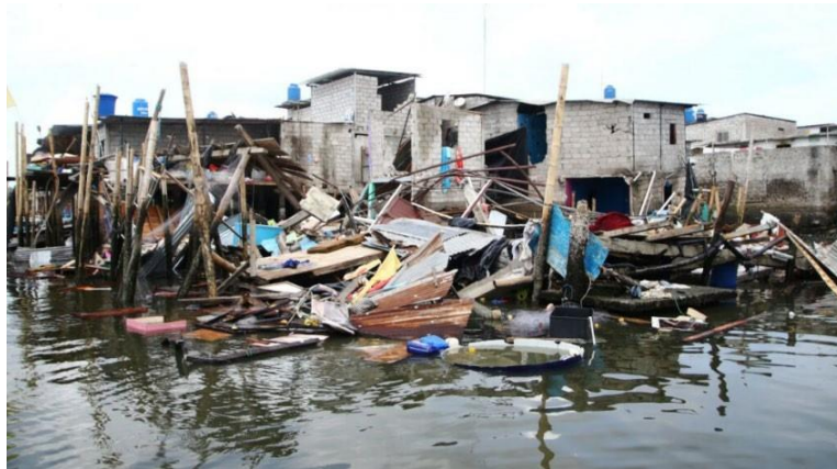
Figura 2 Viviendas colapsadas en el estero Huayla
