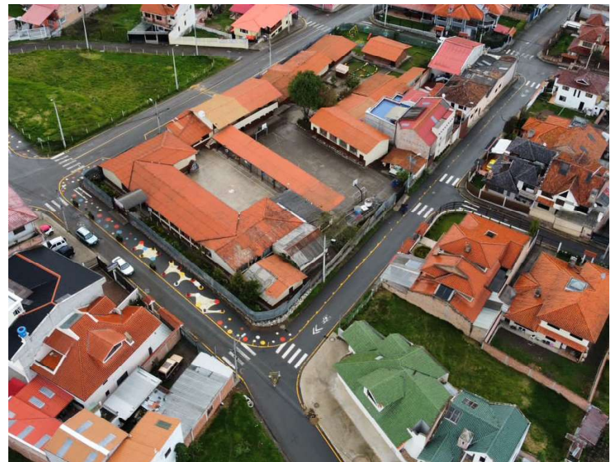
Gráfico 3.20 Fotografía intervención acceso escuela
