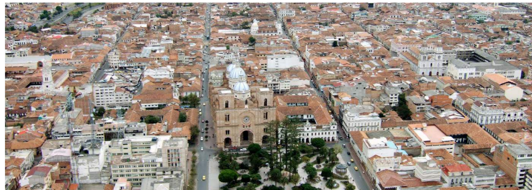
Figura 6. Vista aérea del Centro Histórico de Cuenca. Fuente: I. Municipalidad de Cuenca.
