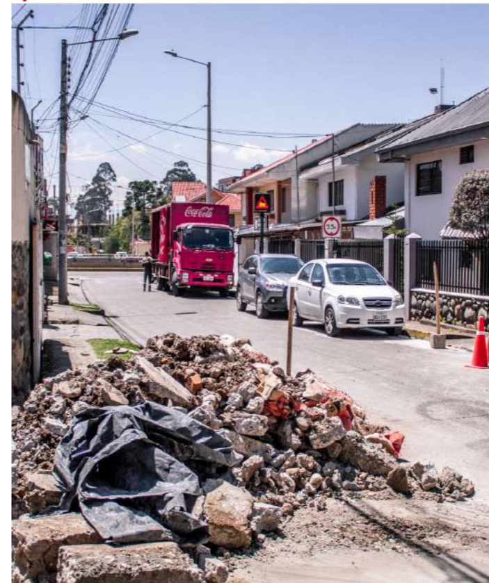
↑ Fig. 35. Reconstrucción de veredas en calle Arrayán.
