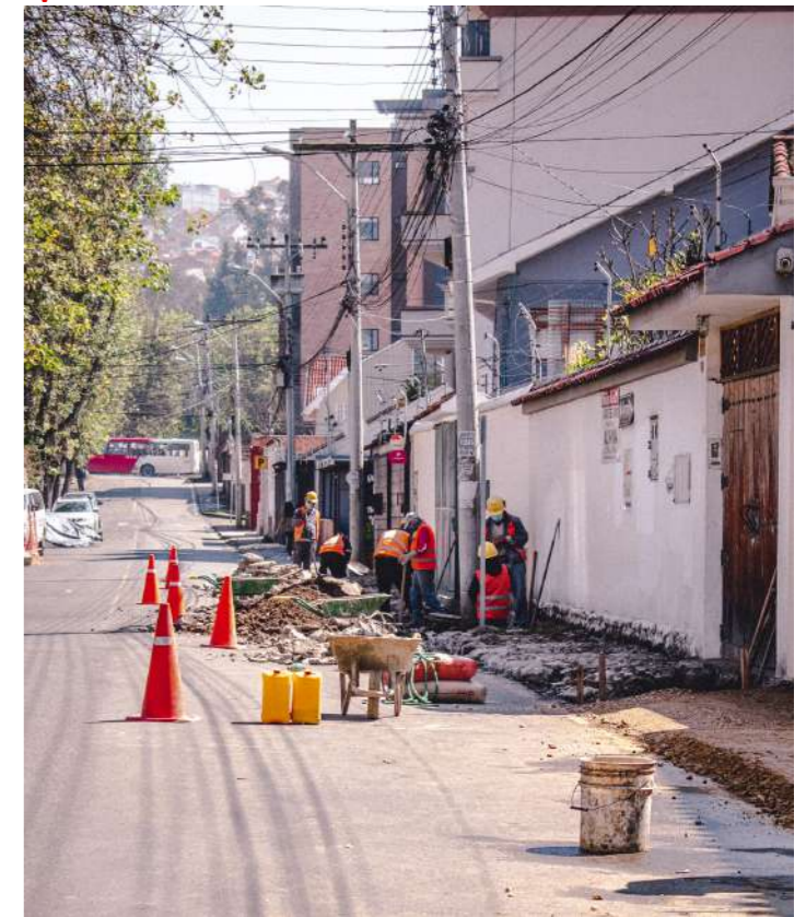
↑ Fig. 36. Reconstrucción de veredas en calle Los Álamos.
