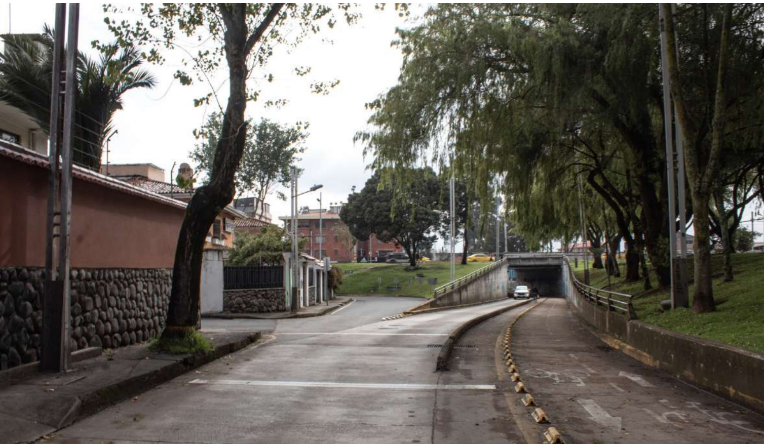
↑ Fig. 71. Estado actual: Vista hacia el paso deprimido de la calle Paseo 03 de Noviembre.
