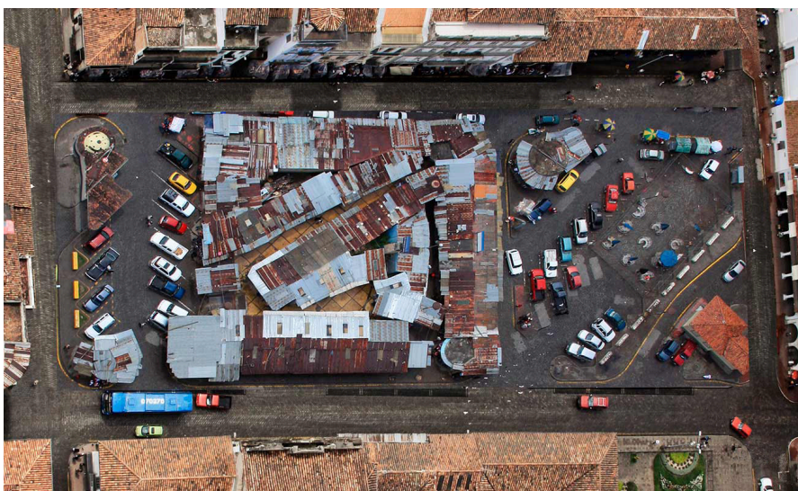
Figura 35 - Plaza San Francisco, estado en el que se encontraba en el año 2016. Fuente: https://www.borisalbornoz.com/plaza-san-francisco-2/
