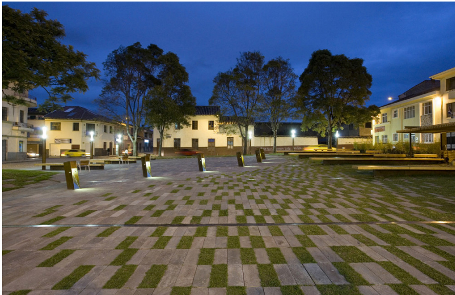
Figura 6 - Plaza Víctor J. Cuesta / DURAN&HERMI-DA Arquitectos Asociados (noviembre 2010). Fuente: Plataforma Arquitectura. Sebastián Crespo.
