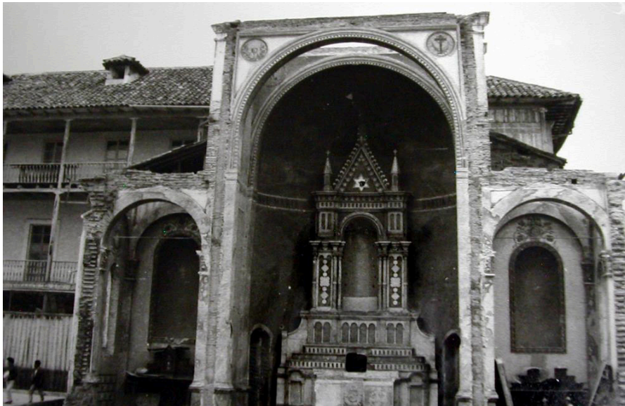
Figura 117 - Ábside y altar de la Iglesia de María Auxiliadora en proceso de demolición. Sin Autor, Sin Fecha. Fuente: Archivo Histórico Fotográfico, Museo Pumapungo.
