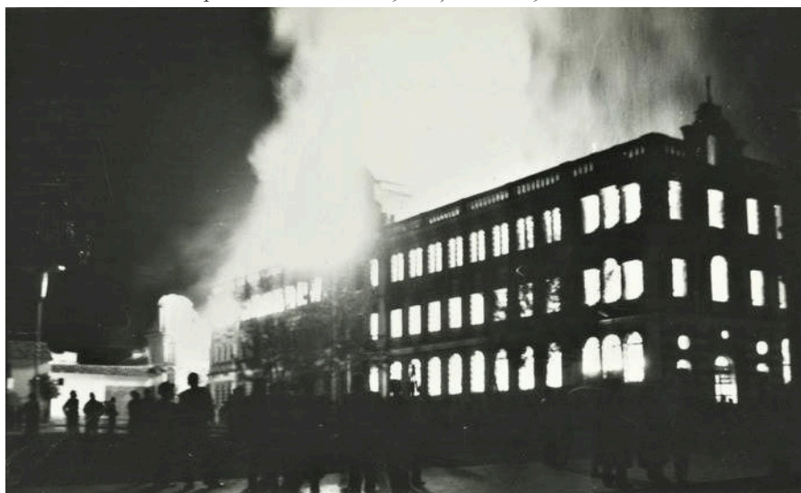
Figura 113 - Fotografía del Incendio que asedió el Instituto Cornelio Merchán, Vicente Tello, 1962. Fuente: Archivo Histórico Fotográfico, Museo Pumapungo.
