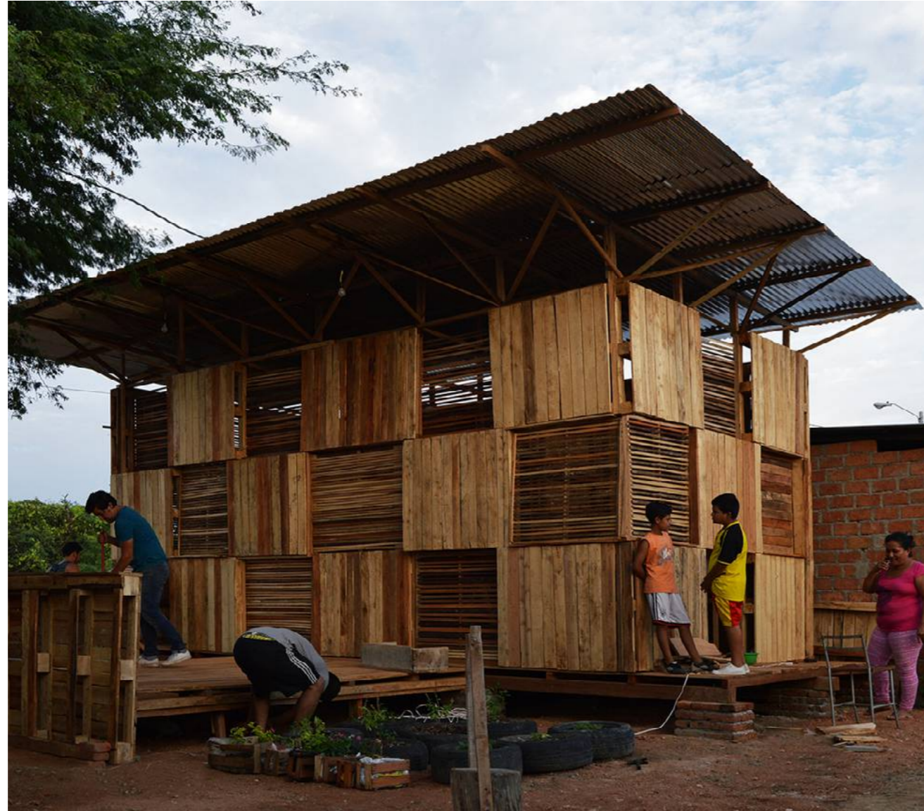
Figura 46 Construcción del Proyecto Chacras, El Oro - Ecuador.
