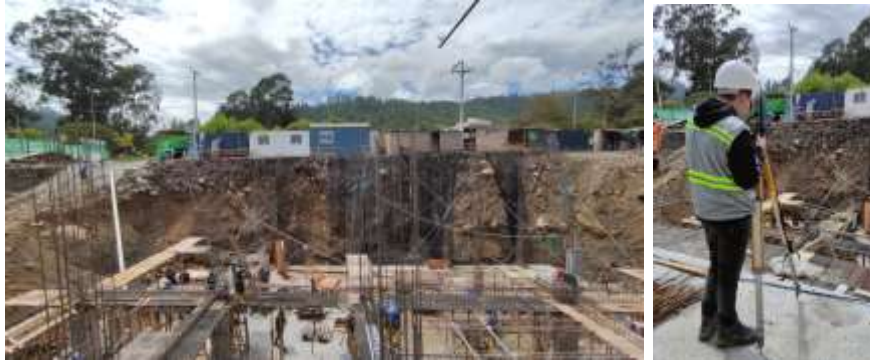
Figura 20. Levantamiento topográfico del talud, en la primera imagen se puede observar los obstáculos para realizar el levantamiento, en la segunda el proceso de levantamiento mediante laser. Fuente: Autor.
