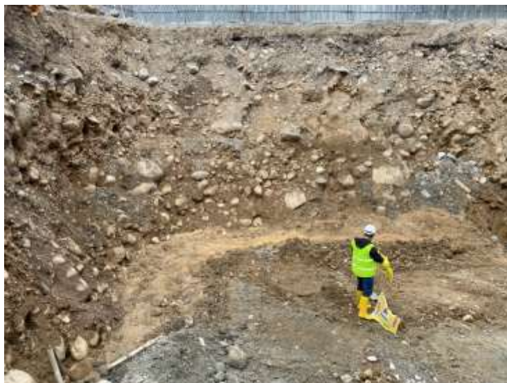
Figura 16. Toma de muestras de material para ensayos triaxiales y a compresión simple. Fuente: Autor
